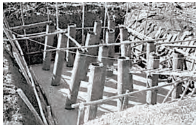
写真2.1.10 東海道新幹線 柳沢高架橋基礎杭 34)
