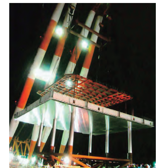
写真2.5.13 栈橋部ジャケットの最終取り付け 32)
