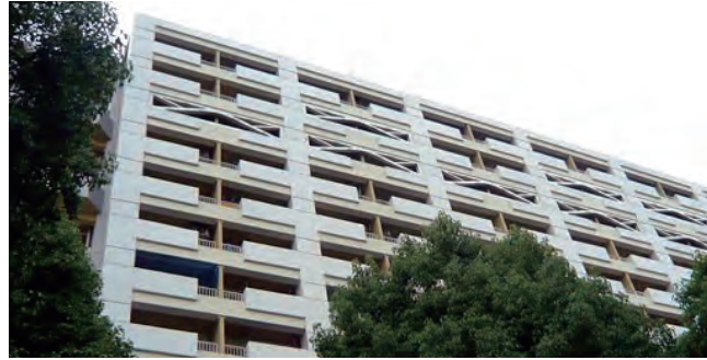
枠付き鉄骨ブレースで補強された住宅階
