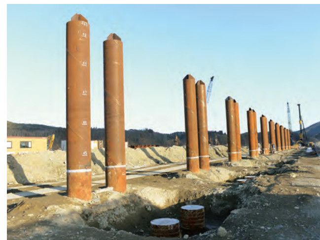
写真3.2.29 打設が終了した鋼管杭の施工状況
