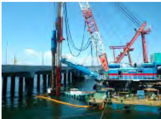
写真3.2.42 ジャケット式防衛施設の鋼管杭打設状況
