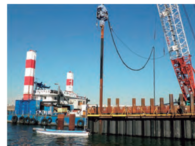
写真2.6.12 バイロハンマによる遮水鋼矢板の打設状況 38) *
