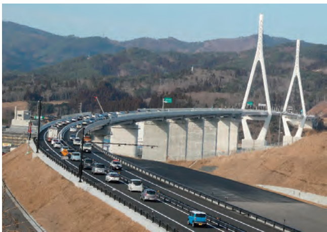
写真2.6.1 開通した気仙沿岸橋を通行する車両 19)
