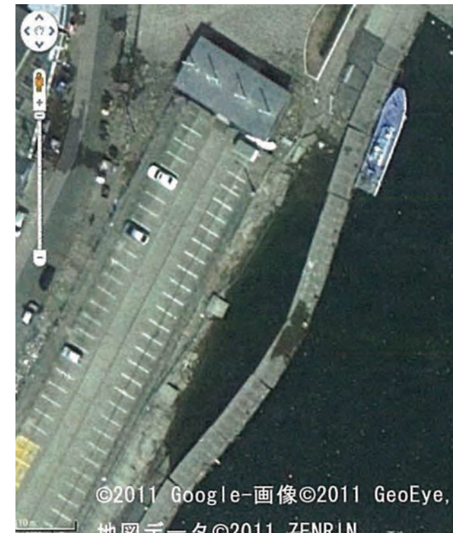
写真2.6.8 那珂湊漁港の被災状況 31)
