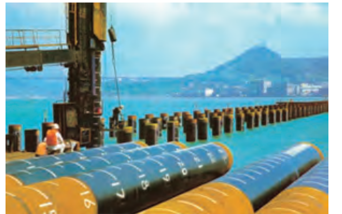
写真2.3.1 ポリエチレン被覆による重防食鋼管杭(黒色部位が被覆材) 7) (写真提供：防食・補修工法研究会)
