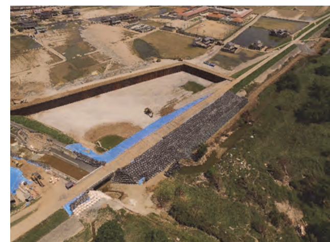
写真3.2.38 鋼矢板二重締切、完了状況
