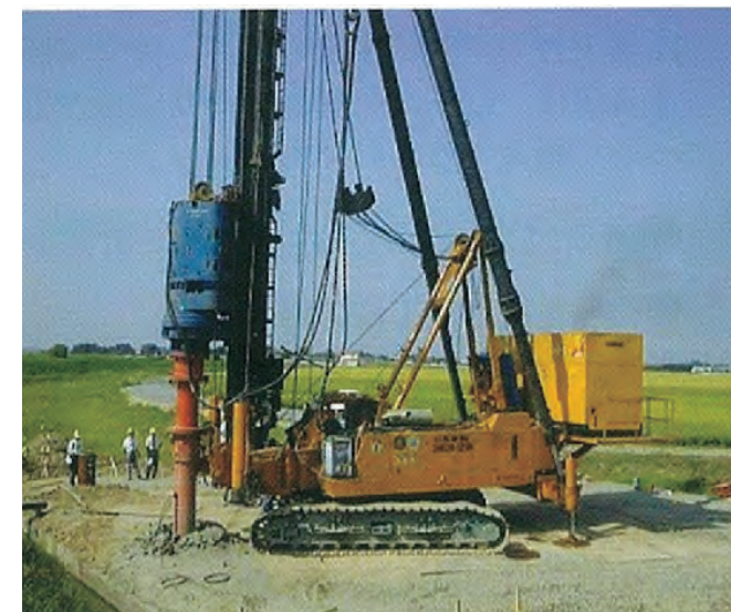
写真 2.5.1 杭頭回転方式の例 9)
