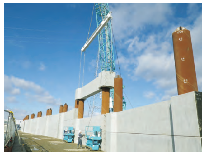
写真3.2.30 杭打設終了後、プレキャストコンクリート壁の設置状況
