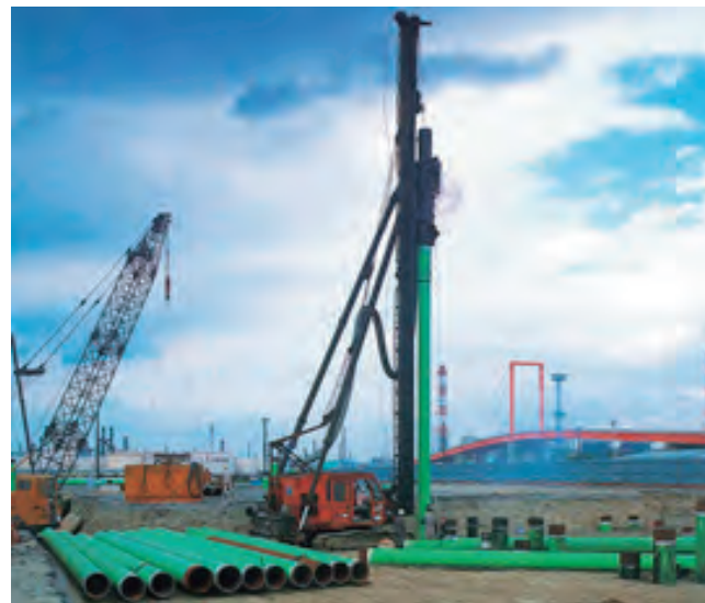
写真2.2.10 ネガティブフリクション低減杭(保護層付きSL杭) 33)
