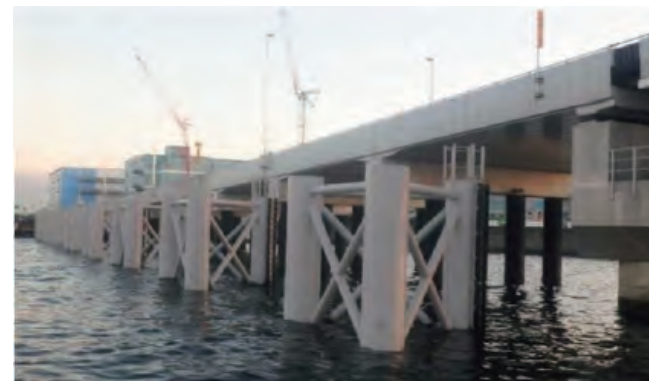
写真3.2.43 ジャケット据付けが完了した防衛施設
