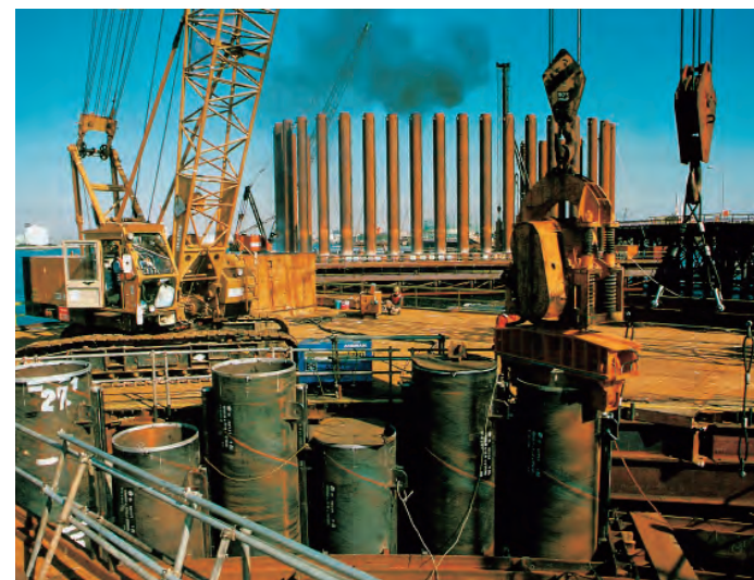
写真2.3.3 東京湾連絡橋基礎 鋼管矢板打設現場写真 8)
