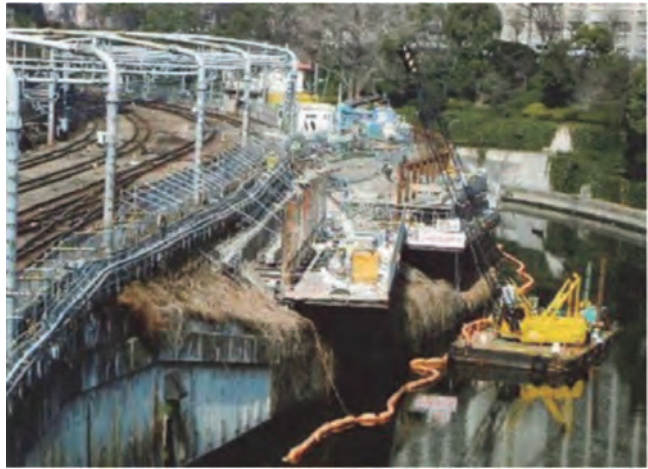
写真2.4.9 御茶ノ水駅付近耐震補強工事 31)
