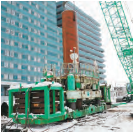
図2.5.4 北陸新幹線 富山駅高架橋工事の回転杭工事の様子 22)
