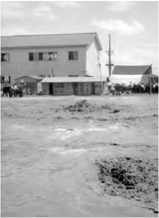
写真2.1.14 新潟明訓高校の校庭で発生した噴砂・湧水 65) (写真提供：関東学院大学 工学総合研究所 若松 加寿江 氏/竹内 寛 氏 撮影)
