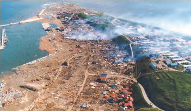
写真3.2.8 津波と火災で壊滅的被害を受けた奥尻島青苗地区（地震調査研究推進本部)
