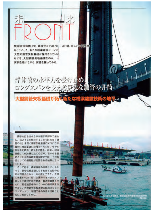
図2.4.7 夢洲・舞洲連絡橋 杭打ち船による鋼管矢板打設風景 23)
