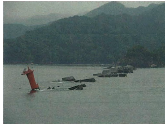
写真2.6.5 釜石湾口防波堤の被害 31)
