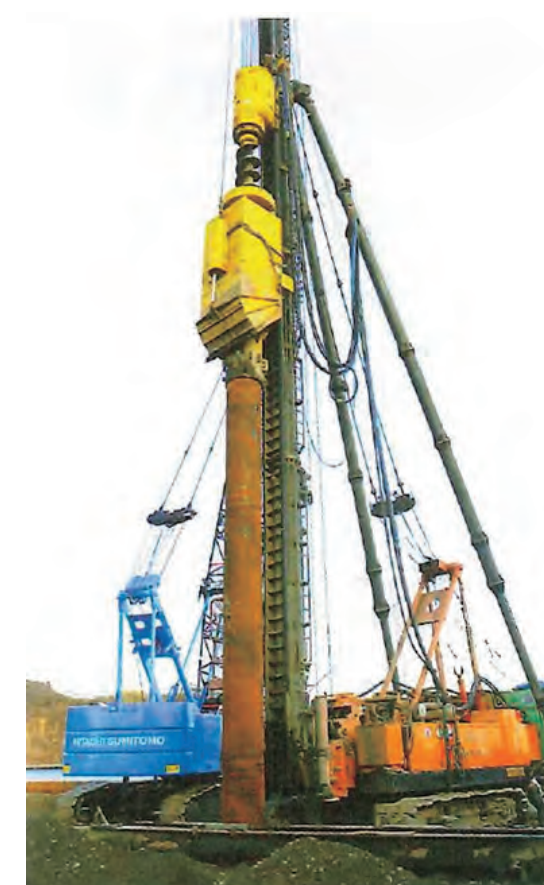
写真2.2.2 中掘り杭打ち機 2)
