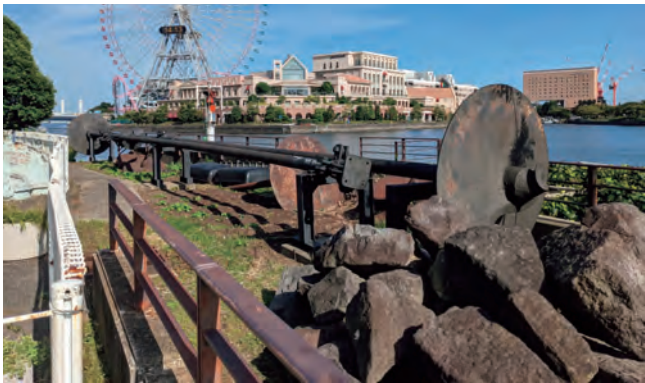
写真2.1.1 横浜港山下大栈橋のスクリューパイル
