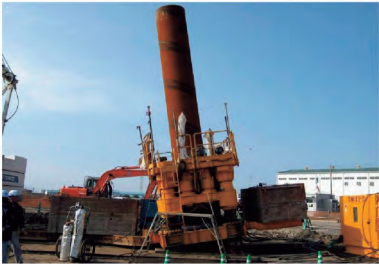
写真 2.5.3 斜杭の施工状況 6)
