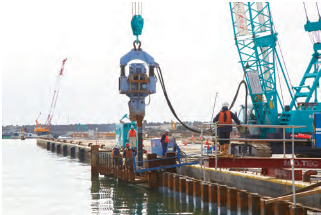
写真3.2.28 設計水深－6m岸壁 鋼矢板打設状況
