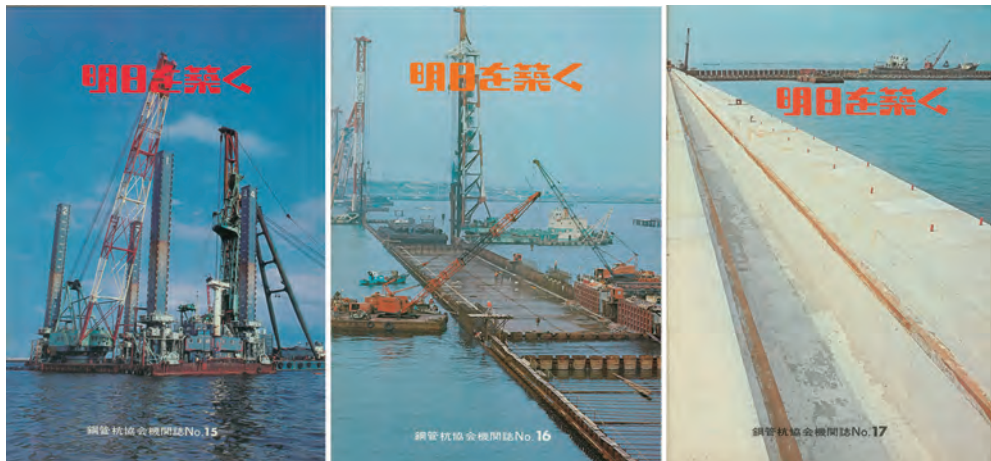
写真2.2.17 いずれも「明日を築く」の表紙に採用された中央防波堤の施工写真 45)～47)
