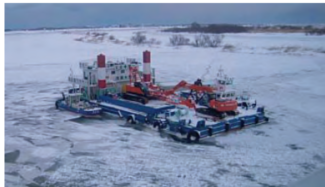
結氷河川内で実施された洗掘対策工
