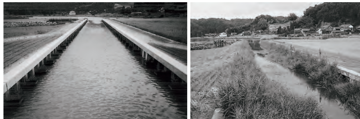
写真2.5.16 植栽フィン工法(左:施工直後、右:施工後3年経過後)
