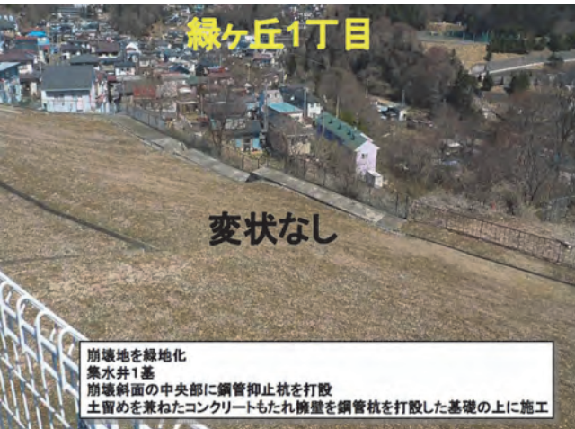
写真3.2.6 鋼管杭で対策し、東日本大震災による被害を回避した
