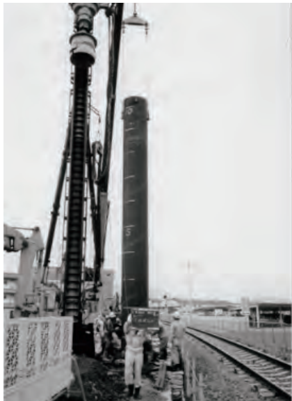
写真2.5.9 JR土讃線連続立体交差事業 高知駅高架橋基礎工事 鋼管ソイルセメント杭の建て込みの様子 20)
