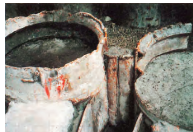
写真2.4.7 西宮大橋 P3継手部調査 24)
