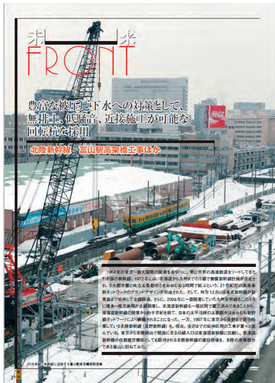
図2.5.4 北陸新幹線 富山駅高架橋工事の回転杭工事の様子 22)
