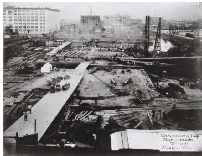
写真2.1.12 旧丸ビル基礎工事写真 58) (写真提供：三菱地所)
