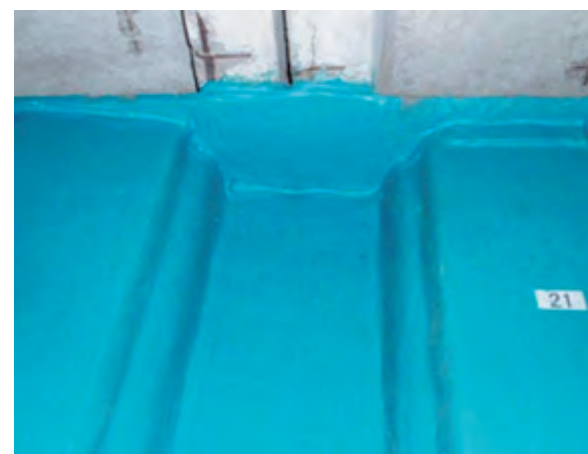
写真2.3.13 水中硬化型被覆工法(パテタイプの鋼矢板への施工例) 30) (写真提供：防食・補修工法研究会)
