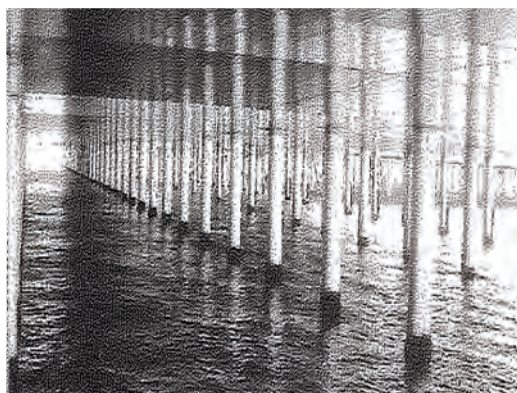
写真2.5.15 耐海水性ステンレス鋼ライニング 32)
