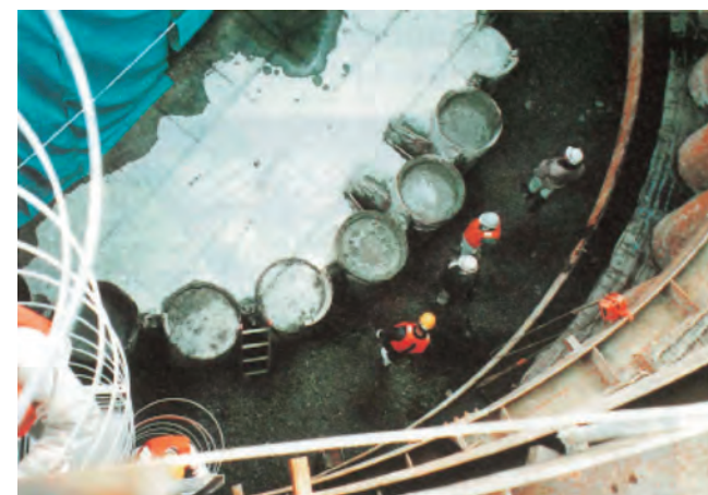
写真2.4.6 西宮大橋 P3橋脚頂版コンクリートひび割れ調査の様子 24)
