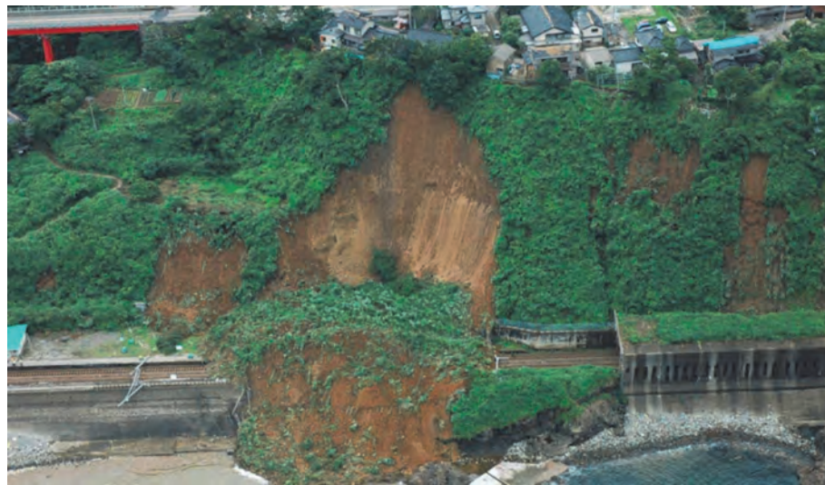
写真3.2.18 土砂災害発生状況（新潟県記録）
