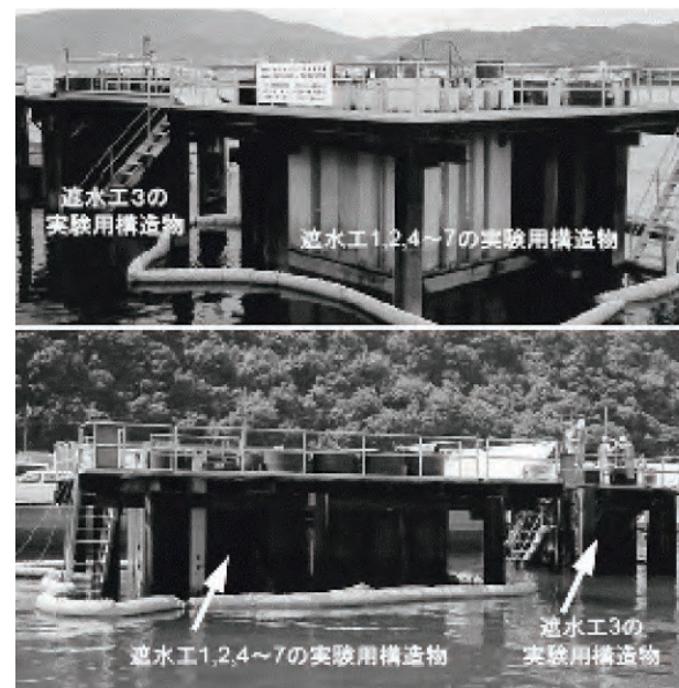
写真2.5.12 実海域遮水性確認のための構造物外観 24) (資料提供: 港湾空港技術研究所)
