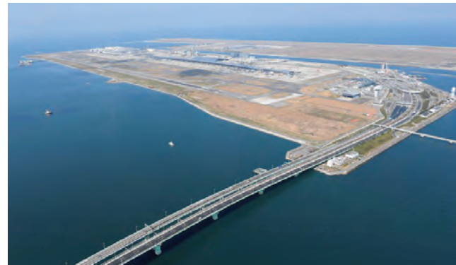
全長3750mの鋼トラス構造を海上部橋脚数29基で支える関西国際空港連絡橋
