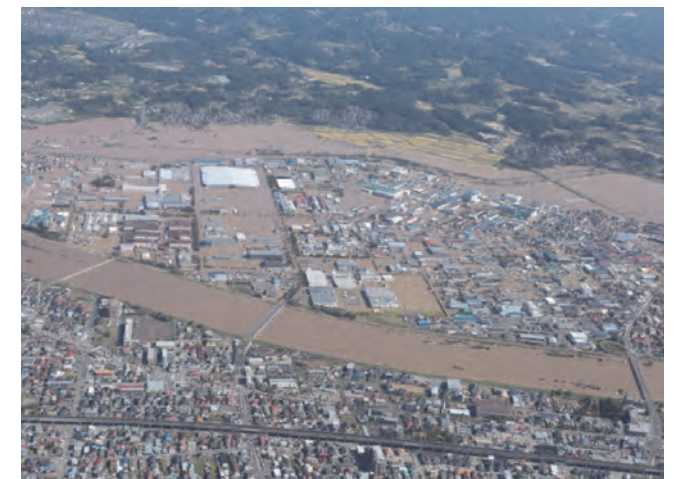
写真3.2.46 阿武隈川の氾濫による郡山市街地の浸水（国土地理院）
