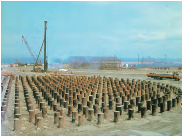
写真2.3.20 LNGタンク部の鋼管杭 40)
