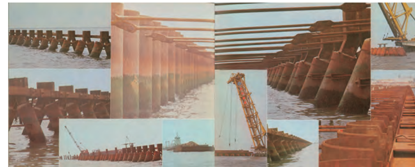
写真2.2.12 大阪港南港の鋼管杭・鋼管矢板 38)
