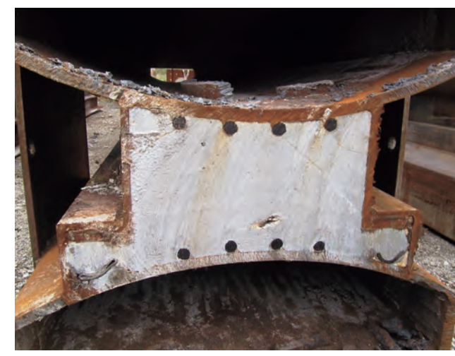
写真2.5.7 Super Junction 16) (写真提供：鹿島建設)
