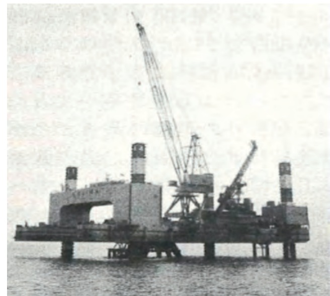
写真2.2.13 出光興産北海道製油所シーバース (万能型海洋工事作業船SEP KAJIMA) 40)
