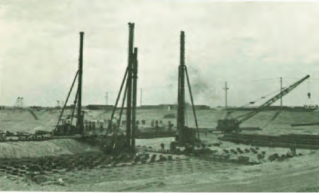
写真 2.2.24 東京電力川崎火力発電所 鋼管杭打設状況 63)
