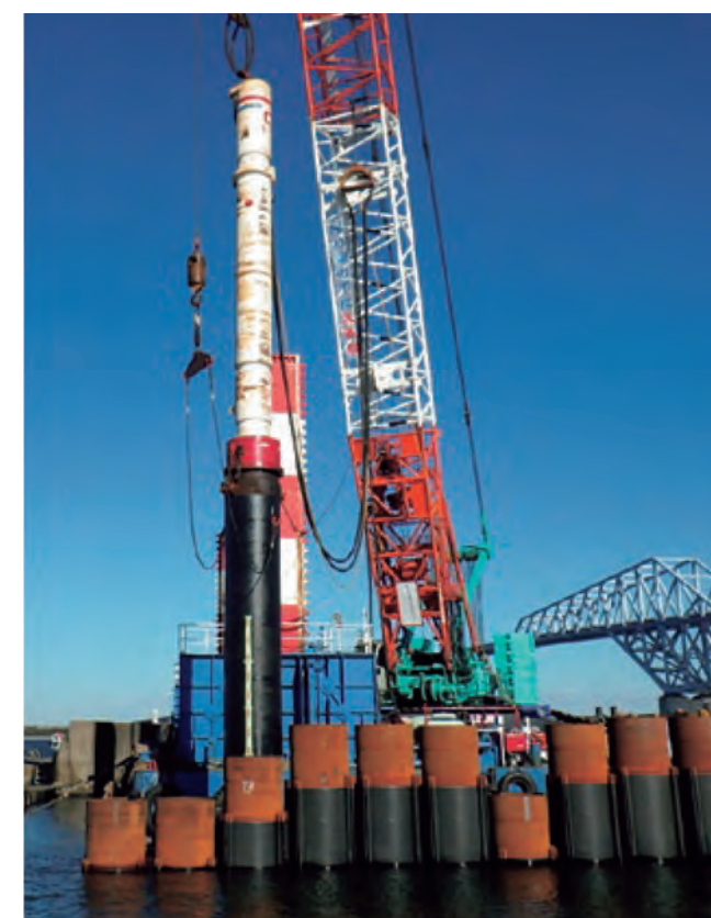
写真2.6.13 東側締切堤 油圧ハンマによる鋼管矢板の打設状況 38) *
