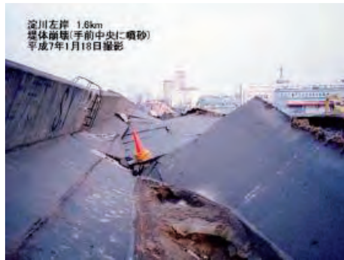
写真 2.4.15 兵庫県南部地震による淀川左岸の被災状況
