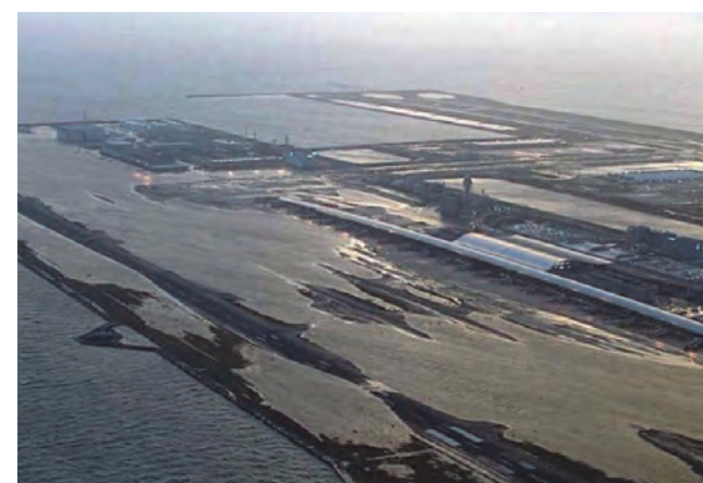
写真3.2.39 浸水した関西国際空港の滑走路（近畿地方整備局）
