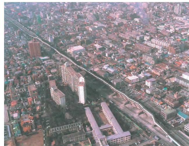
写真2.4.4 兵庫県南部地震(阪神・淡路大震災)での阪神高速神戸線の高架橋の倒壊(神戸市東灘区深江地区) 23)
