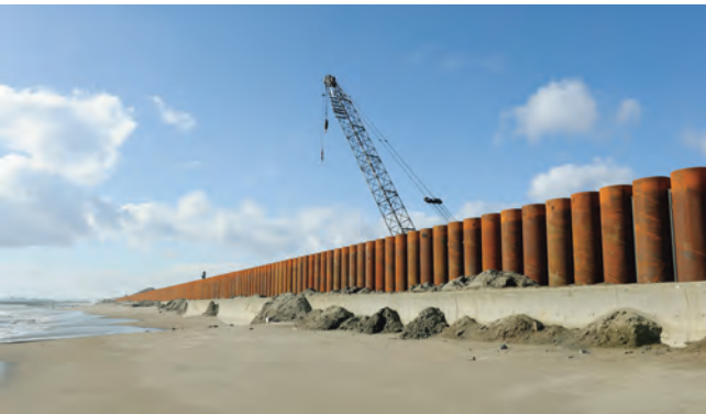
写真3.2.31 石巻港東浜防潮堤の鋼管矢板打設状況
