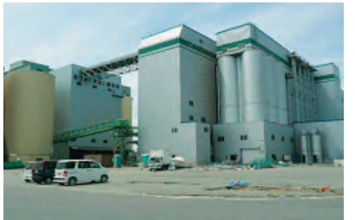
写真2.6.20 宮城県石巻市内の被災建物(飼料工場) 45)
