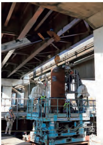
写真2.6.2 高速1号羽田線更新工事(東品川栈橋・鮫洲埋立部)での低空頭圧入機での施工の様子 24)
