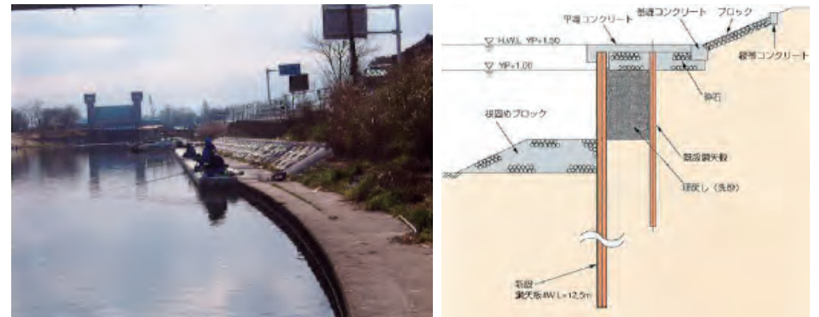
図2.5.14 「鋼矢板・鋼管矢板を使用した護岸リニューアル事例集」で紹介される老朽化護岸の改修事例/中島護岸(国土交通省霞ヶ浦河川事務所)
