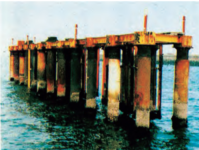
写真2.2.20 千葉沖における防食鋼管杭暴露状況 53)
