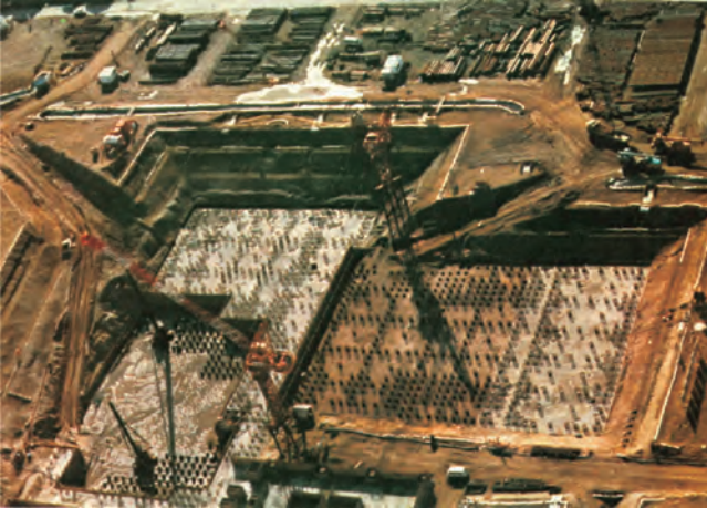
写真 2.2.25 東京電力鹿島火力発電所 第4期工事状況 63)
