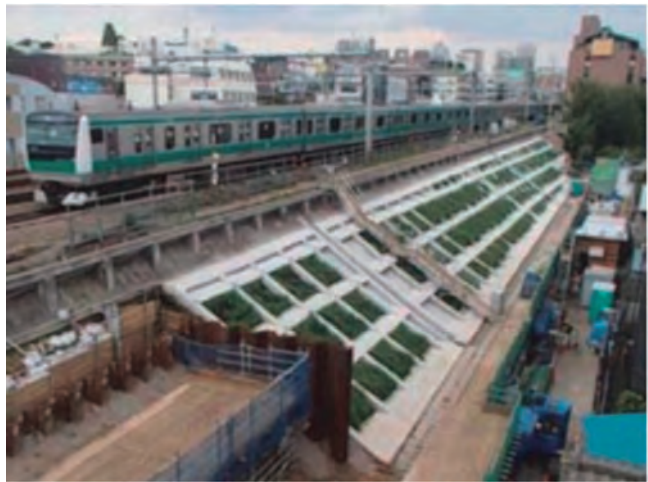
写真2.4.10 耐震補強工事後(高田馬場駅～目白駅間) 31)
