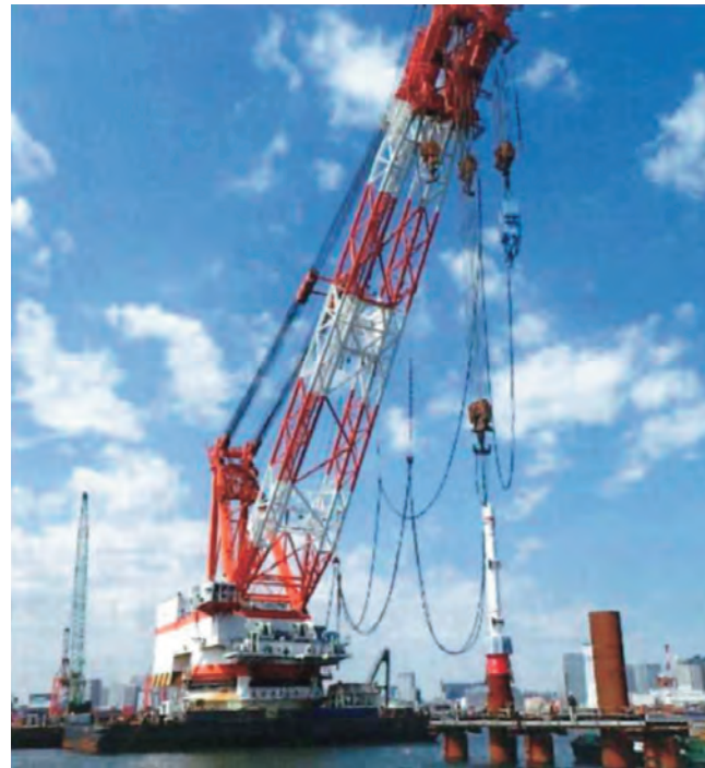
写真2.6.17 東京国際クルーズターミナル 鋼管杭打設状況 42)
