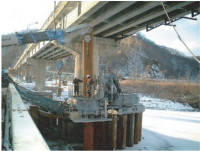
写真2.4.3 北海道平取町での橋脚補強工事 13) (2003年8月台風10号と同年9月十勝沖地震により基礎部が先掘され傾斜した橋脚補強工事で既設ケーソン基礎を補強する鋼管矢板圧入施工の事例)
