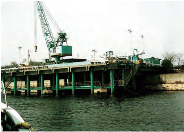
写真2.4.12 クボタ鉄管積出し棧橋(健全) 35)
