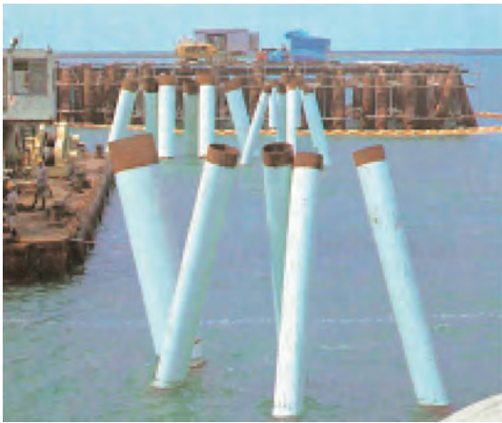
写真2.3.21 LNGバース部の鋼管杭 40)
