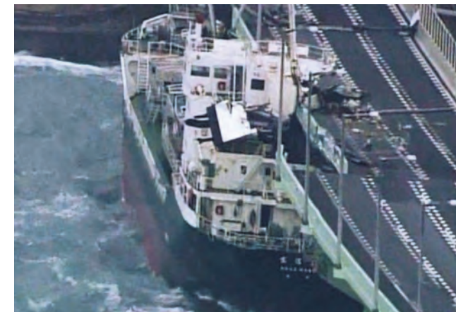
写真3.2.40 タンカーが衝突した関空連絡橋
