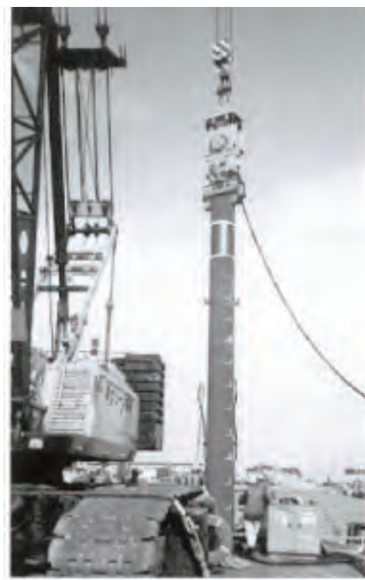
写真2.5.5 パイプロハンマ工法の施工風景 10)
