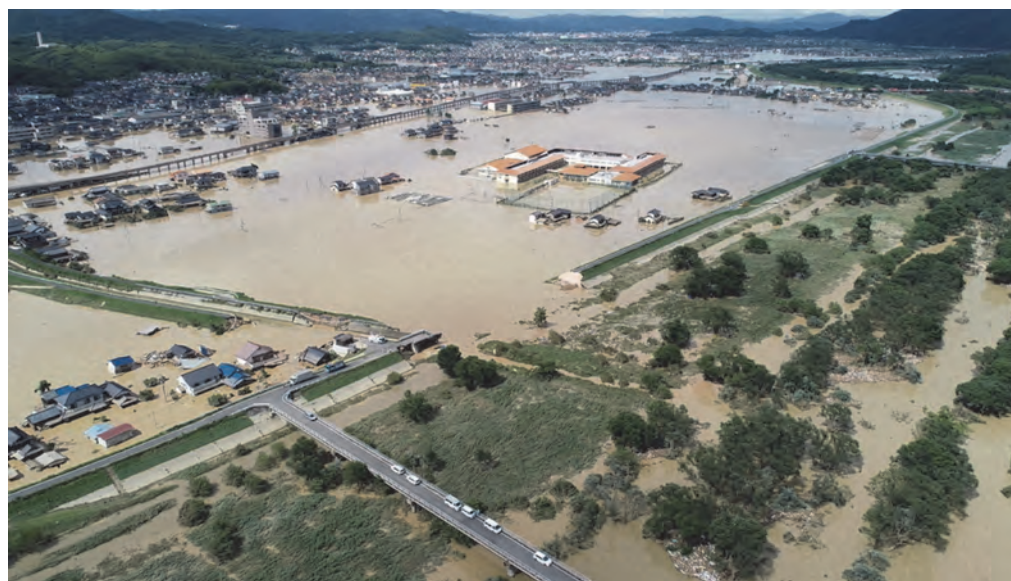
写真3.2.36 決壊した小田川の堤防（国土交通省中国地方整備局）
