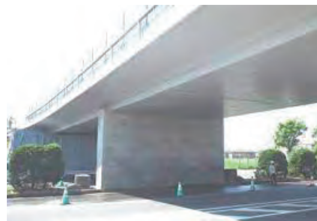
写真 3.2.34 完全自立構造の橋脚として改良復旧した
