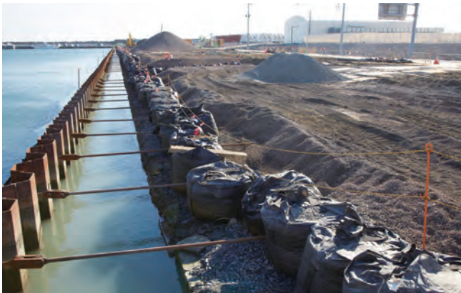
写真3.2.27 設計水深－7m岸壁 新設の控え式構造による復旧施工（中詰施工前）
