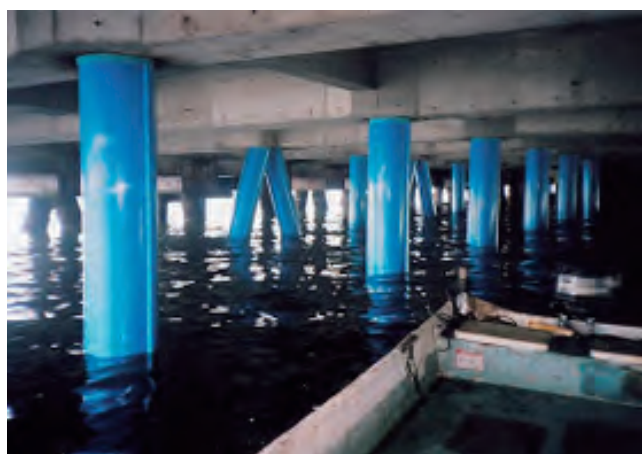
写真2.3.12 ペトロラタム被覆工法 鋼管杭橋への適用例 30) (写真提供：防食・補修工法研究会)
