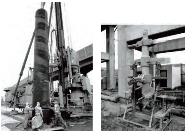
写真2.5.8 名古屋臨海高速鉄道西名古屋港線での鋼管ソイルセメント杭施工と掘削攪拌ヘッド 18)
