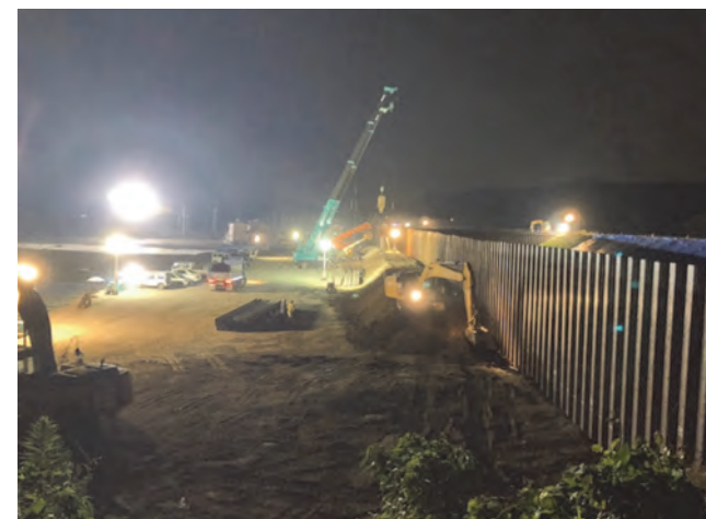
写真3.2.37 24時間体制で打設される鋼矢板二重締切
