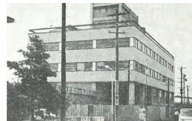
写真3.2.2 新潟総合通信部庁舎全景（かさ上げ前）
