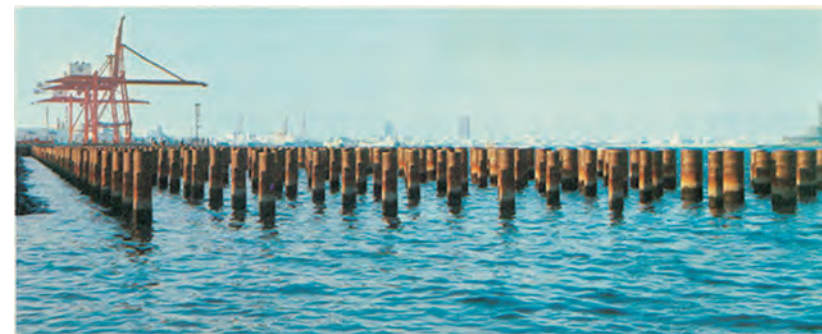
写真2.2.11 大井コンテナバース鋼管杭 37)
