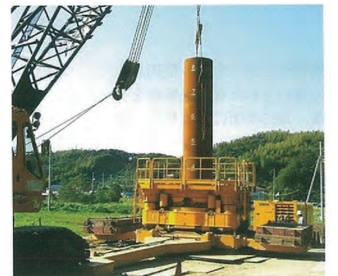
写真 2.5.2 胴体回転方式の例 9)
