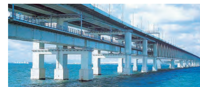
写真2.3.15 超厚膜型被覆工法の例(関西国際空港連絡橋) 30) (写真提供：防食・補修工法研究会)
