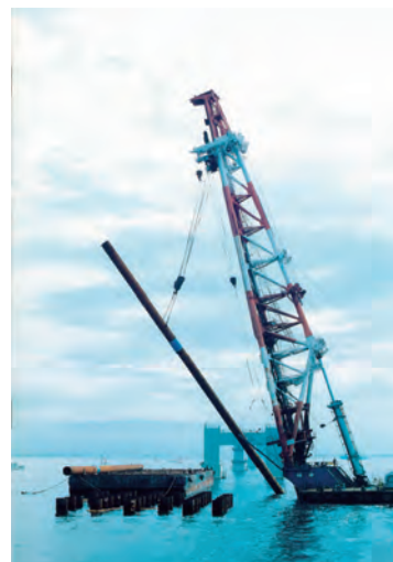
写真2.3.4 関西国際空港連絡橋基礎杭の打設風景 10)
