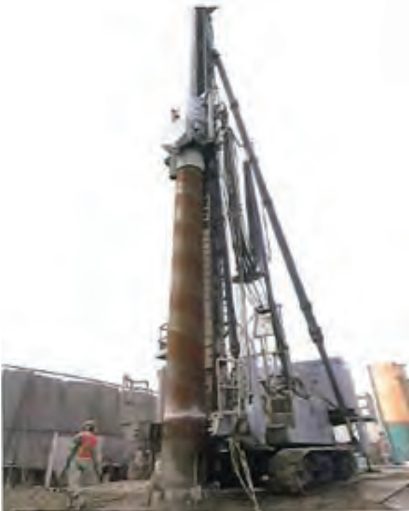
写真2.4.1 鋼管ソイルセメント杭工法 杭打ち機 9)
