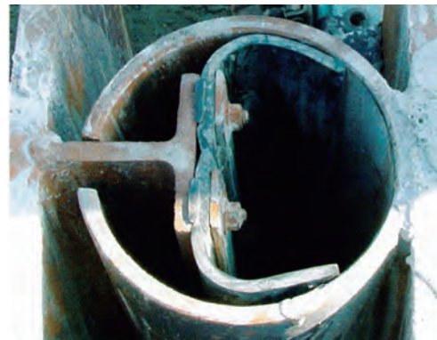
打設後の嵌合状況
