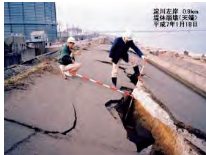
写真 2.4.15 兵庫県南部地震による淀川左岸の被災状況
