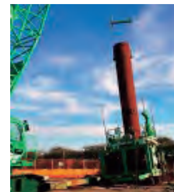
写真2.6.4 東海環状自動車道(大野神戸IC～大垣西IC)本線ランプ橋の斜杭施工 27)
