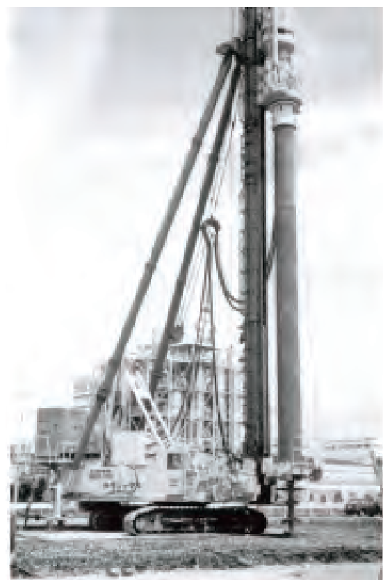
写真2.5.4 鋼管ソイルセメント杭工法の施工風景 10)
