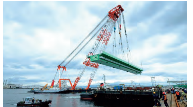
走錨事故による損傷からの復旧桁の架設状況（2019年2月）
