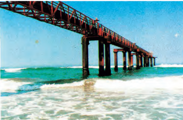
写真2.2.21 阿字ヶ浦沖における防食鋼管杭暴露状況 53)
