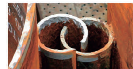
縞鋼管継手嵌合状況
