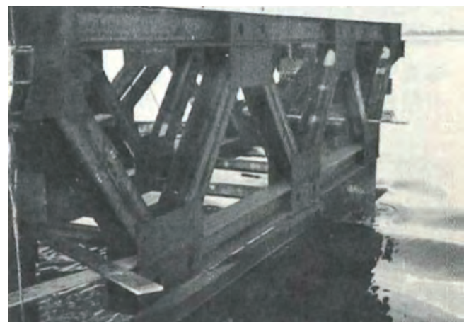
写真2.2.14 IHI知多ドッグ艦装用けい船施設(杭頭連結鉄骨支保工) 40)
