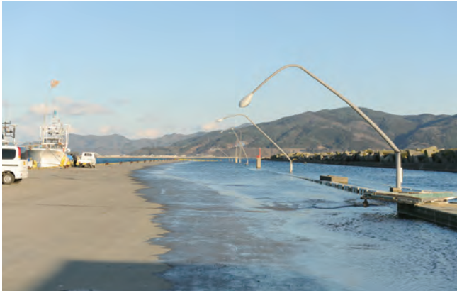
写真3.2.26 設計水深－7m岸壁 被災被災状況
