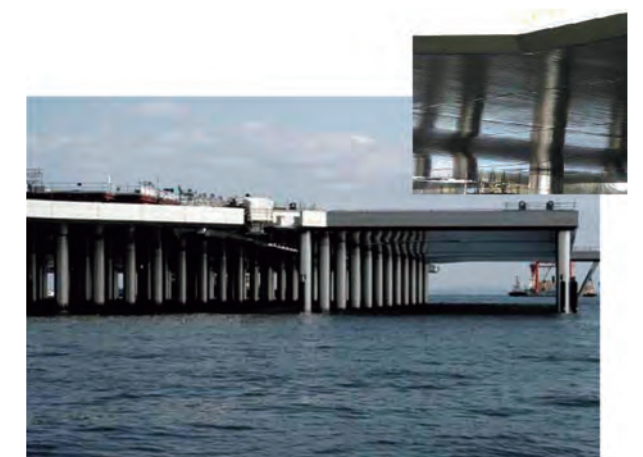
写真2.5.14 チタンカバークレープが採用された新滑走路栈橋部 31)
