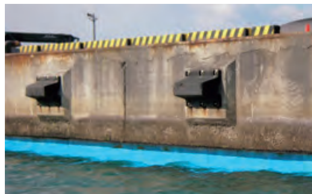
写真2.3.11 モルタル被覆工法の岸壁への適用例 30) (写真提供：防食・補修工法研究会)
