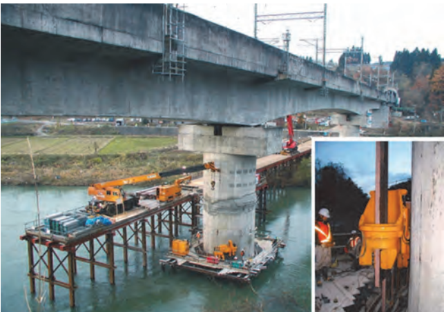
写真3.2.17 鋼矢板巻立て耐震補強工法の施工状況
