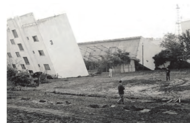
写真3.2.1 液状化により大きく傾斜した県営川岸町アパート3号棟（左）と4号棟（中央）。4号棟は転倒して屋上が見えている。外壁には亀裂ひとつ生じていない。
