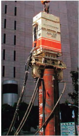
(b) 油圧式 17) 写真2.2.3 バイプロハンマ
