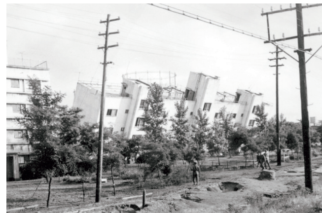
写真2.1.13 液状化により傾いた県営川岸町アパート 65) (写真提供：関東学院大学 工学総合研究所 若松 加寿江 氏/竹内 寛 氏 撮影)
