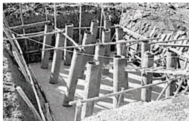
写真2.1.10 東海道新幹線 柳沢高架橋基礎杭 34)
