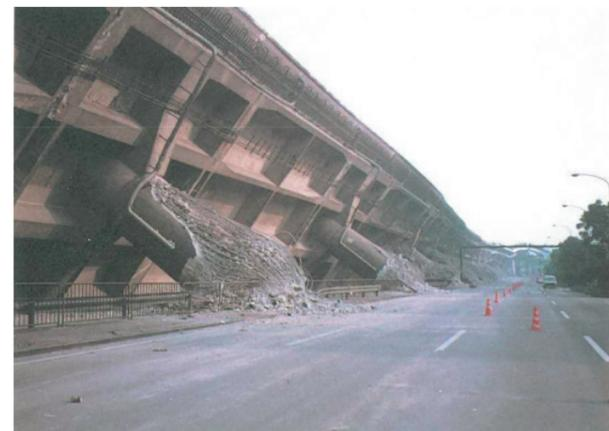
写真2.4.5 兵庫県南部地震(阪神・淡路大震災)での阪神高速神戸線の高架橋の倒壊(神戸市東灘区深江地区)<sup>23)</sup>
