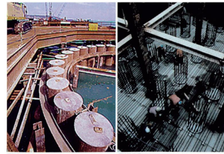
写真2.4.8 古宇利大橋の鋼管矢板基礎と鋼管杭基礎<sup>20)</sup>
