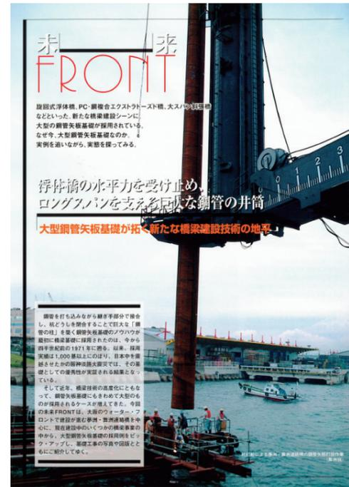
図2.4.7 夢洲・舞洲連絡橋 杭打ち船による鋼管矢板打設風景<sup>23)</sup>
