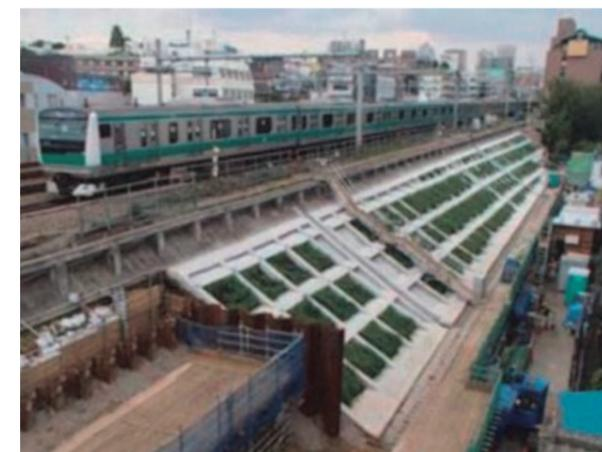
写真2.4.10 耐震補強工事後(高田馬場駅～目白駅間)<sup>31)</sup>
