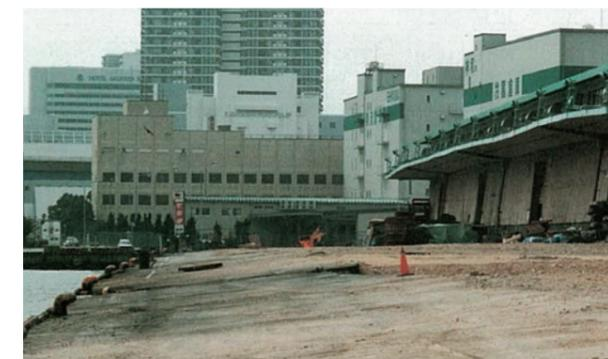
写真2.4.17 ケーソン岸壁の前傾による、鋼管杭基礎と構造物の傾き<sup>41)</sup>
