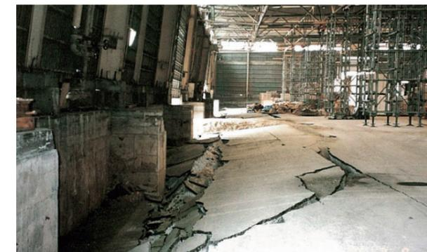
写真2.4.18 フーチングの移動により陥没した床版<sup>41)</sup>
