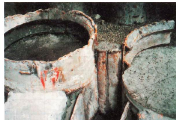
写真2.4.7 西宮大橋 P3継手部調査<sup>24)</sup>
