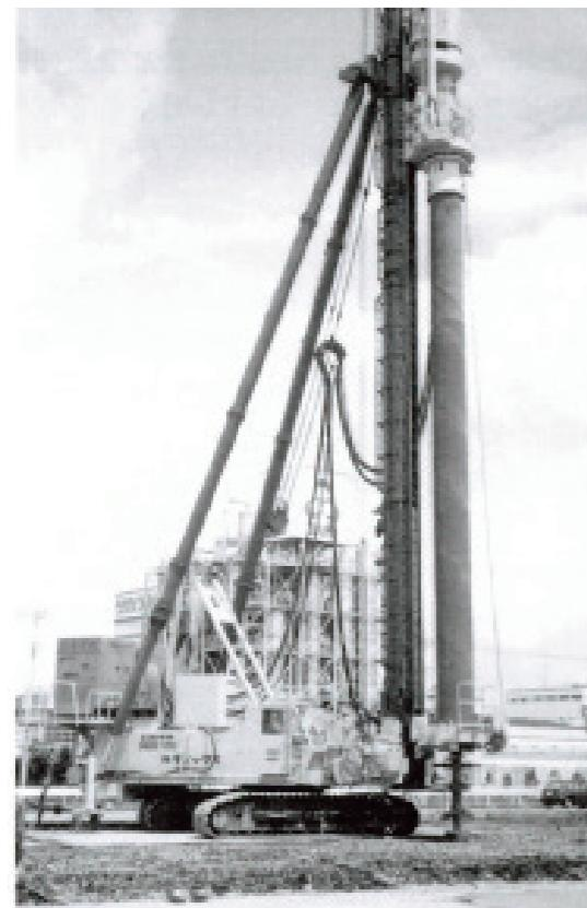
写真2.5.4 鋼管ソイルセメント杭工法の施工風景<sup>10)</sup>
