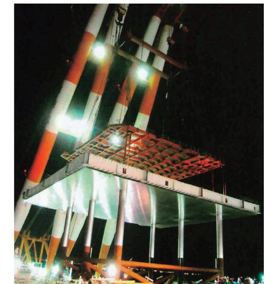
写真2.5.13 桟橋部ジャケットの最終取り付け<sup>32)</sup>
