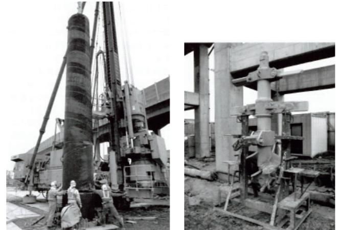
写真2.5.8 名古屋臨海高速鉄道西名古屋港線での鋼管ソイルセメント杭施工と掘削攪拌ヘッド<sup>18)</sup>
