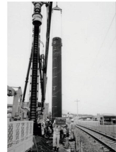
写真2.5.9 JR土讃線連続立体交差事業 高知駅高架橋基礎工事 鋼管ソイルセメント杭の建て込みの様子<sup>20)</sup>
