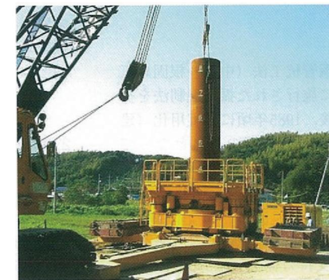
写真2.5.2 胴体回転方式の例<sup>8)</sup>
