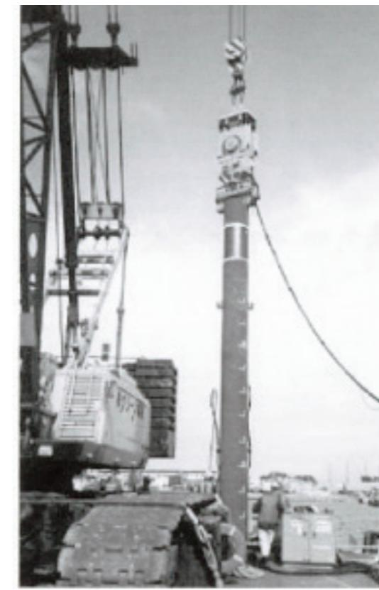
写真2.5.5 バイプロハンマ工法の施工風景<sup>10)</sup>
