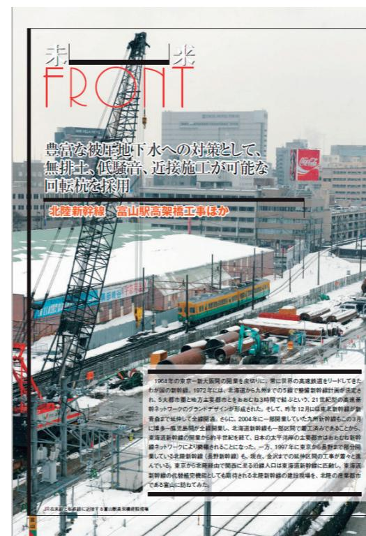
写真2.5.4 北陸新幹線 富山駅高架橋工事の回転杭工事の様子<sup>22)</sup>
