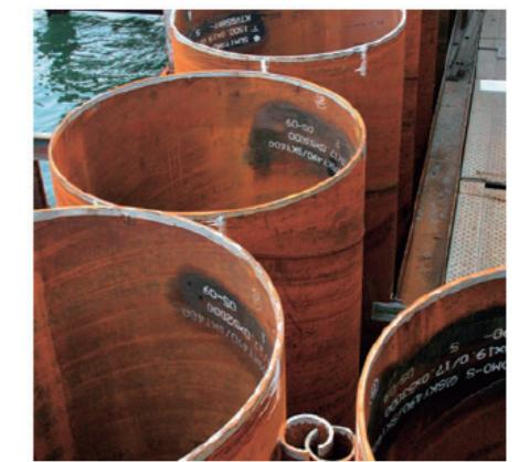
写真2.5.3 東京港臨海大橋(現 東京ゲートブリッジ)で採用された縞钢管高耐力継手<sup>14)</sup>
