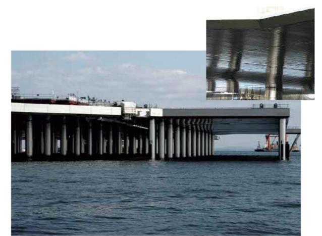
写真2.5.14 チタンカバープレートが採用された新滑走路桟橋部<sup>31)</sup>
