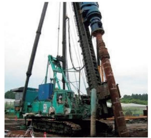
写真 2.5.3 斜杭の施工状況<sup>6)</sup>
