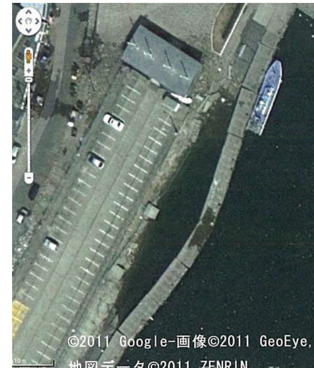
写真2.6.8 那珂湊漁港の被災状況 31)
