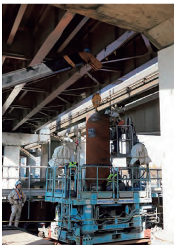
写真2.6.2 高速1号羽田線更新工事(東品川栈橋・鯉洲埋立部)での低空頭圧入機での施工の様子 24)
