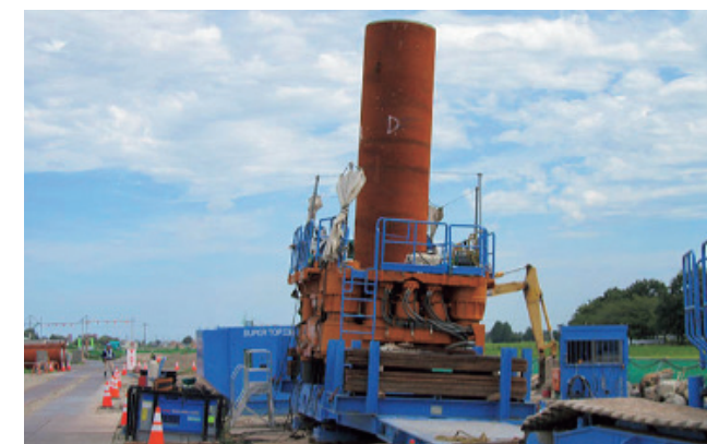
写真2.6.3 北陸新幹線延伸工事(金沢～敦賀間)小松木場湯高架橋の斜杭施工 26)
