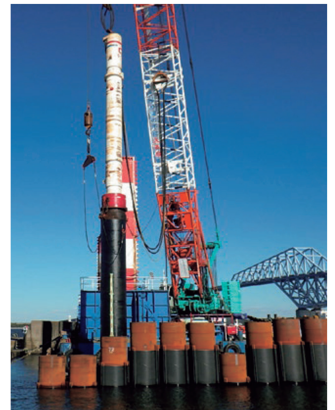
写真2.6.13 東側締切堤 油圧ハンマによる鋼管矢板の打設状況 38) *
