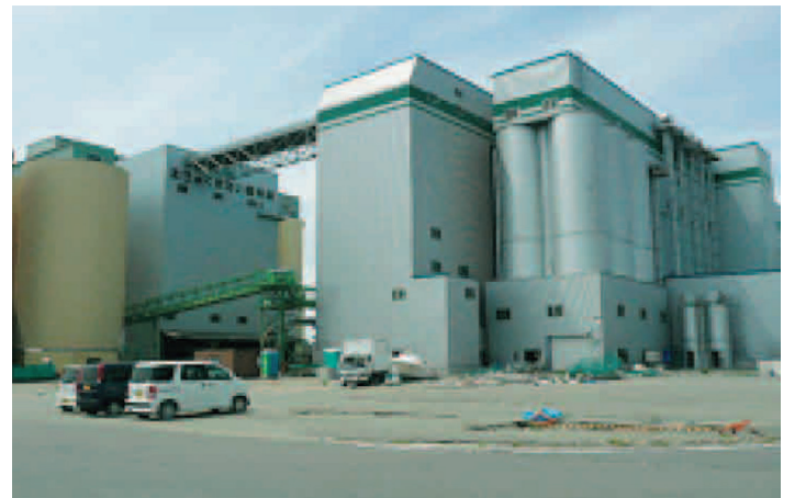
写真2.6.20 宮城県石巻市内の被災建物(飼料工場) 45)
