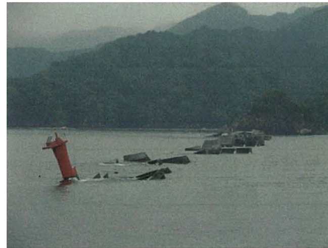
写真2.6.5 釜石湾口防波堤の被害 31)
