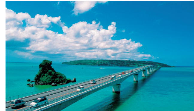
マリンプルーを渡る古宇利大橋
