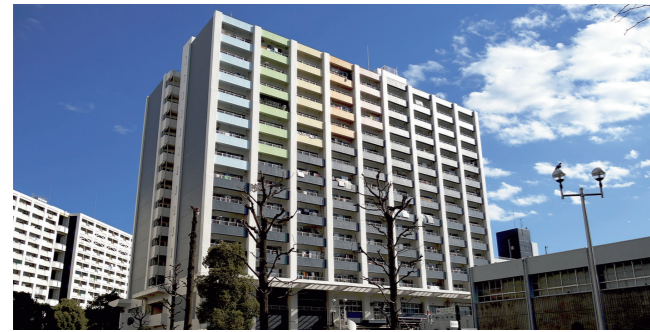
アソートカラーの対比で現代的な外壁改修を施した川口芝園団地
