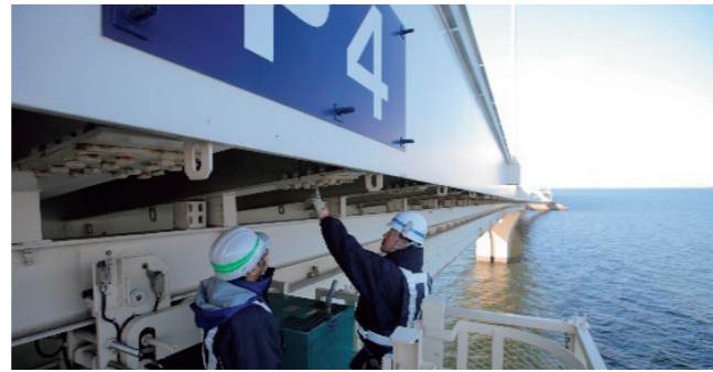
点検台車を用いたアクアブリッジの点検・補修状況
