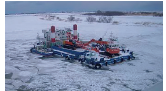
結氷河川内で実施された洗掘対策工
