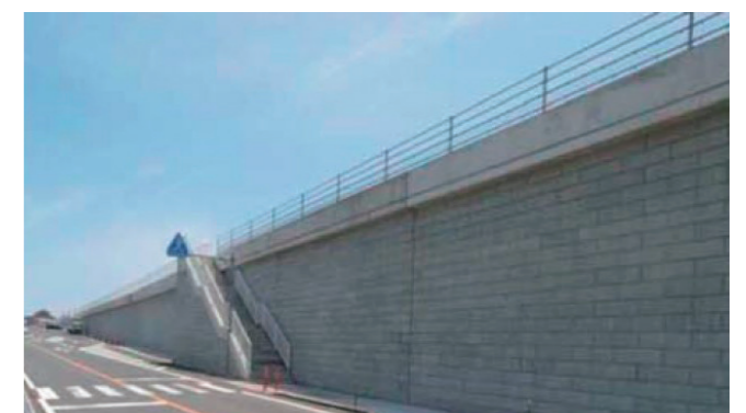
改良工事が完了した新居海岸の海岸堤防
