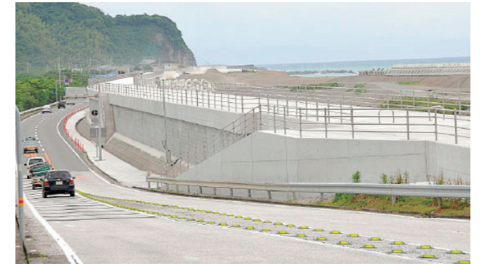
改良工事が完了した仁ノ海岸の堤防
