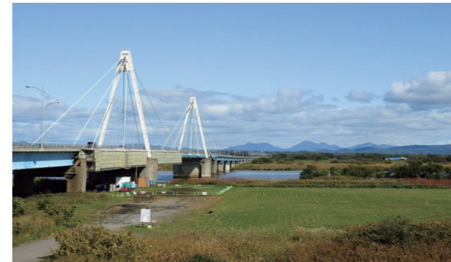
石狩川の最下流部、河口から約5kmの地点にある石狩河口橋(左岸側より)
