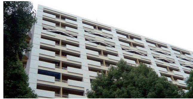
枠付き鉄骨プレースで補強された住宅階
