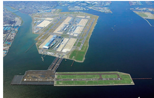
東京国際空港D滑走路の全景（写真下側）
