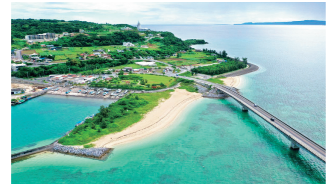
橋詰めに整備された古宇利ビーチ
