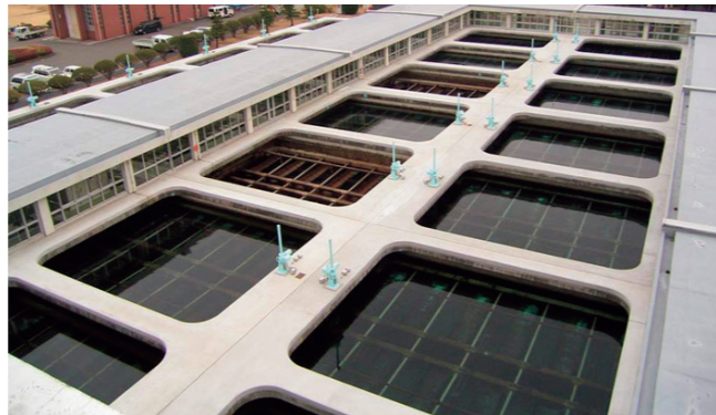
耐震工事が完了したろ過池の状況(2021年)
