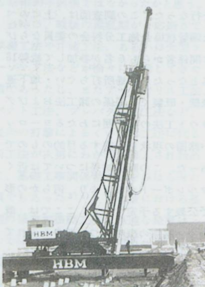
ハノーバー国際見本市では、異色の出品として Hoesch 社の低音くい打撃機があつた。この機械は、写真 4 にみられるごとくエヤハンマーの周囲に防音用のケース（内面に防音材使用、断面：2m×2m で八角形、高さ 18m）を
