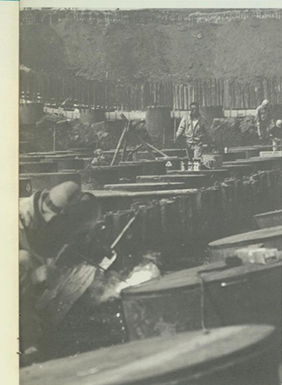
既製ぐいの使用区分は、水平力が基礎に作用するものはすべて鋼管ぐいとし、くい長が14~21メートルと比較的短い鉛直荷重のみのくいにはP Cくいが使われた。
