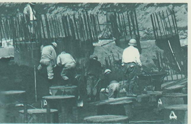
もくいが配置できなくなったので、斜ぐいの採用や基礎面を深さ2.0メートルにわたって砂で置換して基礎地盤のK値(地盤反力係数)を改良した。
