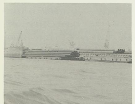
南埠頭で使用される鋼管ぐいは95トン、鋼管矢板4,456トン合計4,551トンである。
