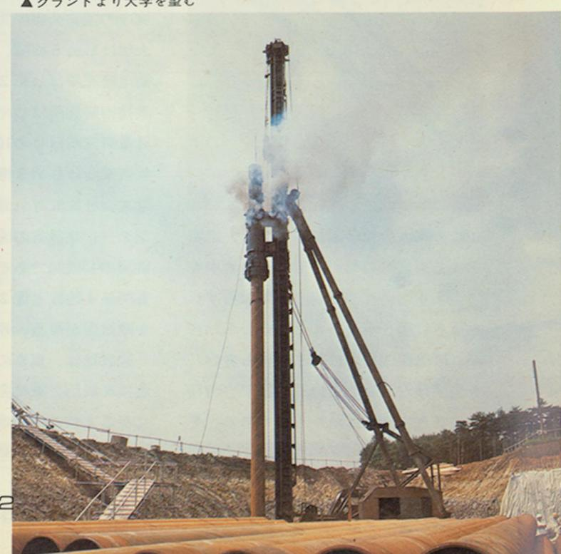
上9階建、地表よりバラベット上端まで42.25m、建築面積1,912m<sup>2</sup>、建築床面積3,154m<sup>2</sup>、厚壁棟1,735m<sup>2</sup>、薄壁棟1,419m<sup>2</sup>、建物重量が30,755トンと建築面積に比べて、建物重量がひじょうに大きいこと、そして地質調査から深度52m、N値50以上を支持地盤として決定した。すなわち、厚壁棟の中央部9階建部分に集中する荷重に対応する基礎ぐいは、1本当りの支持力の大きなものが要求され、支持地盤の深さとも考え合わせて、鋼管ぐいの採用が決定づけられたのである。
