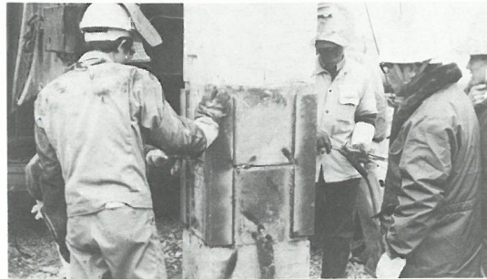
中国製RCぐいの施工
