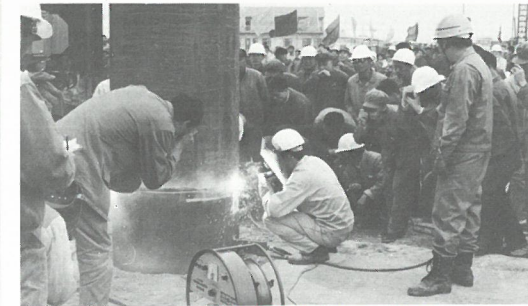
日中共同による宝山製鉄所最初の本ぐい施工
