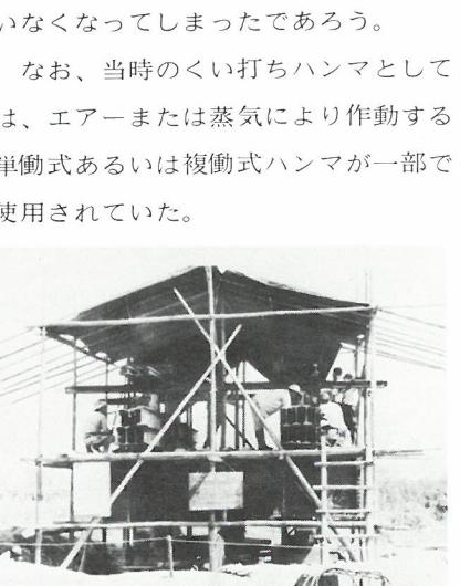
写真-1 試験工事におけるくい打ヤグラと載荷試験
