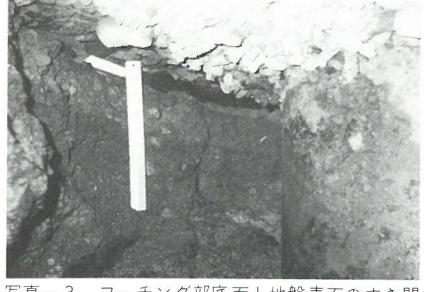
写真-3 フーチング部底面と地盤表面のすき間
