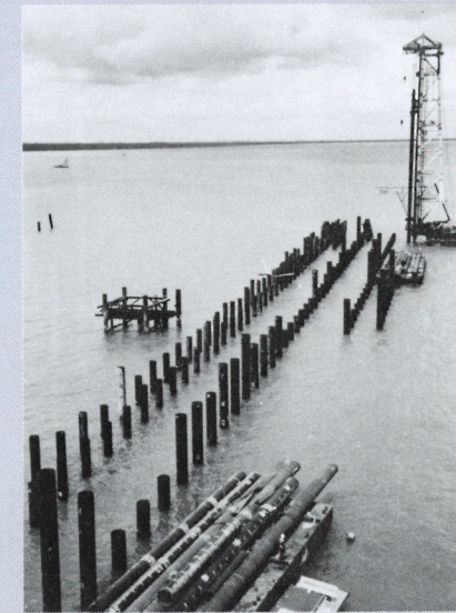
棧橋部分の杭打工事
