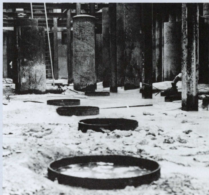
ポンプ室基礎杭
