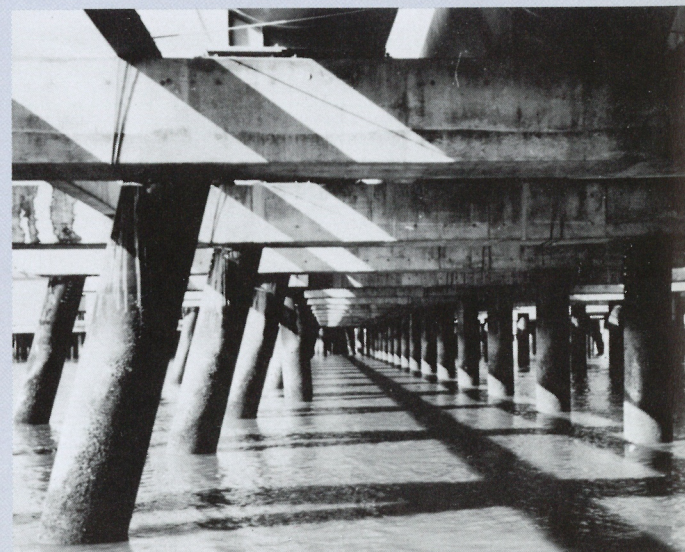
パイプガントリー。渡橋（2）下部
