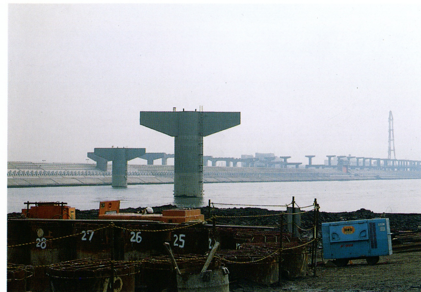
KE線の重要部分を支える鋼管矢板基礎
