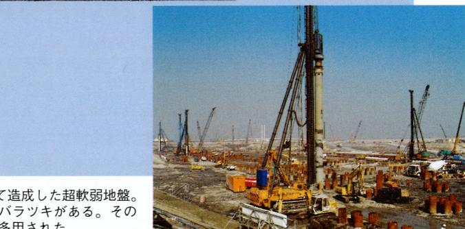
沖合展開用地は、浚渫ヘドロの上に建設残土を埋め立てて造成した超軟弱地盤。しかも支持層までは50~74mというように深くしかもバラツキがある。そのため継ぎ杭が可能で、港湾施設でも実績を持つ钢管杭が多用された。
