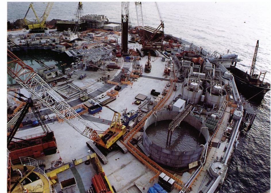
建設中の川崎人工島。建設時にはシールド発進基地として使用され、完成後は換気塔としての役割を果たしている。帆船のイメージに仕立てられた換気塔には「風の塔」の名称が付けられた。
