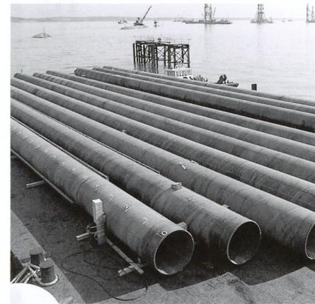
外径1,200mmの钢管矢板。海上輸送の利点を活かして最長43.5mの钢管矢板が使用されている。
