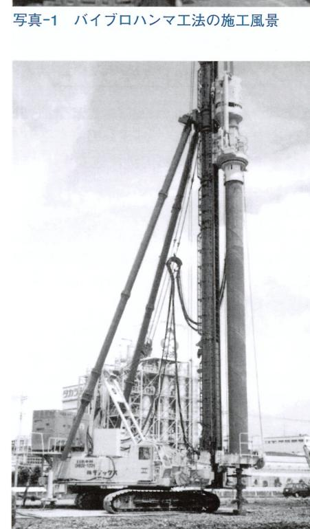
写真-1 バイブルハンマ工法の施工風景
