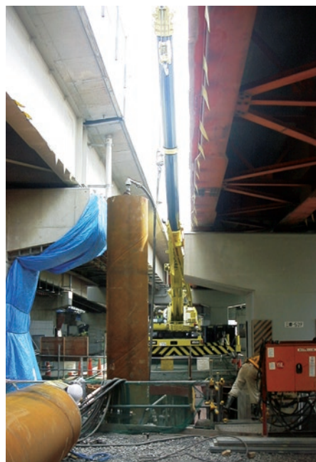
既設路線を供用しながら施工される
