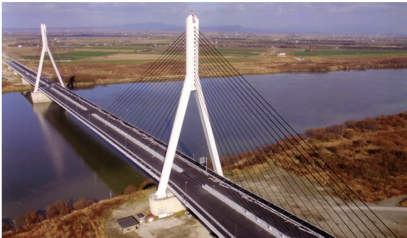
江別側より美原大橋全景。一面吊鋼斜張橋としては世界的な規模ゆえ、80mにもなる逆Y形状の主塔が必要となった。
