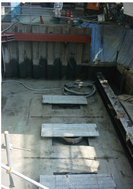
施工後の状況
