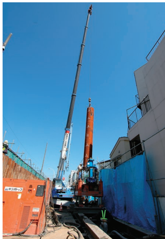
住宅が隣接する狭隘な現場
