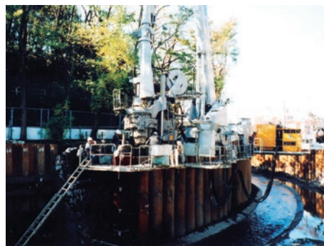
圧入工法による打設の様子
