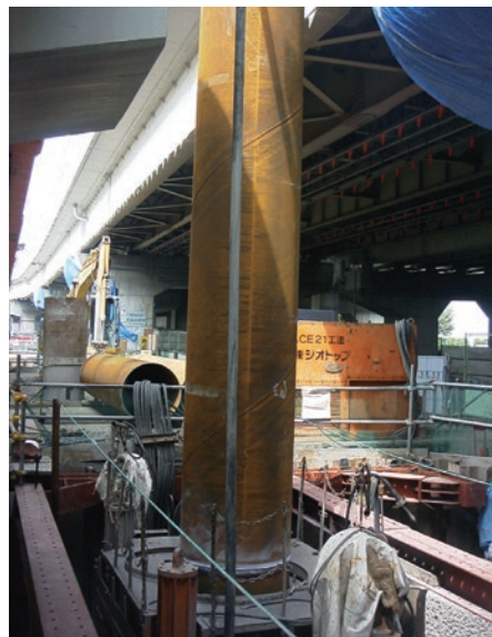
低空頭下での鋼管杭施工状況
