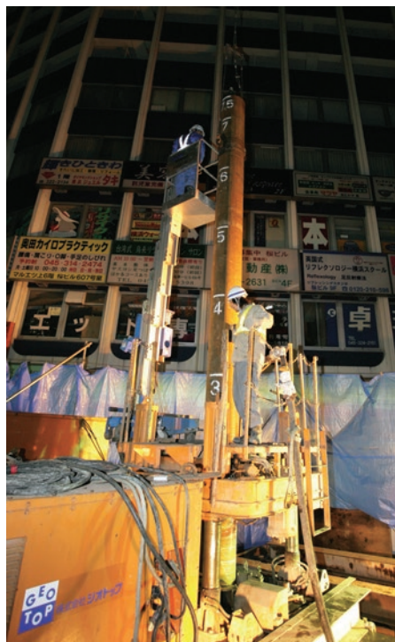
過密な駅周辺での施工
