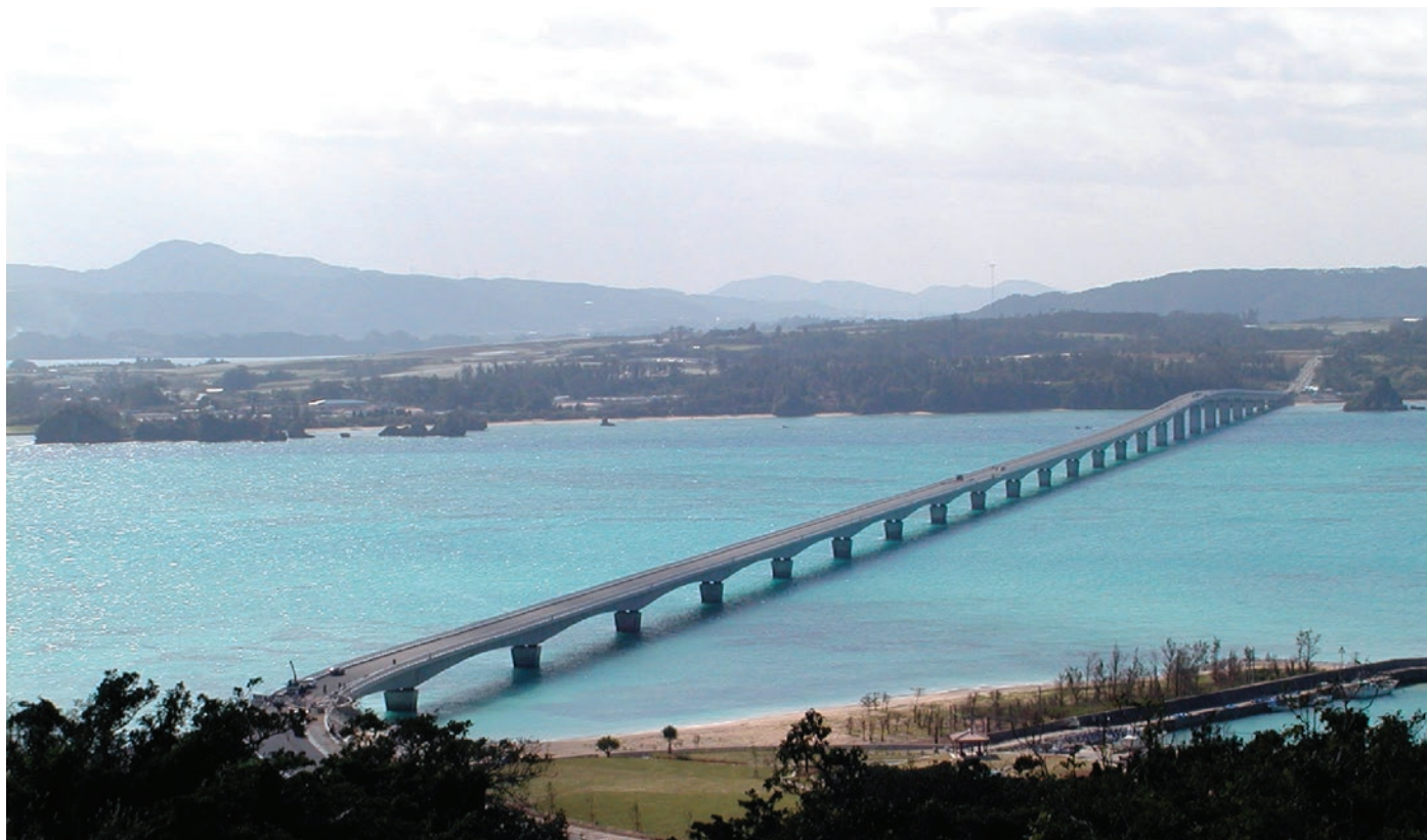
開通になった古宇利大橋全景(古宇利島側より)
