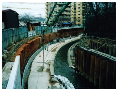
新護岸、および既存護岸の根固めに打設された鋼管矢板
