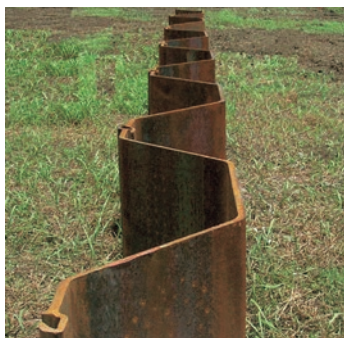
写真1 ハット形鋼矢板打設後状況
