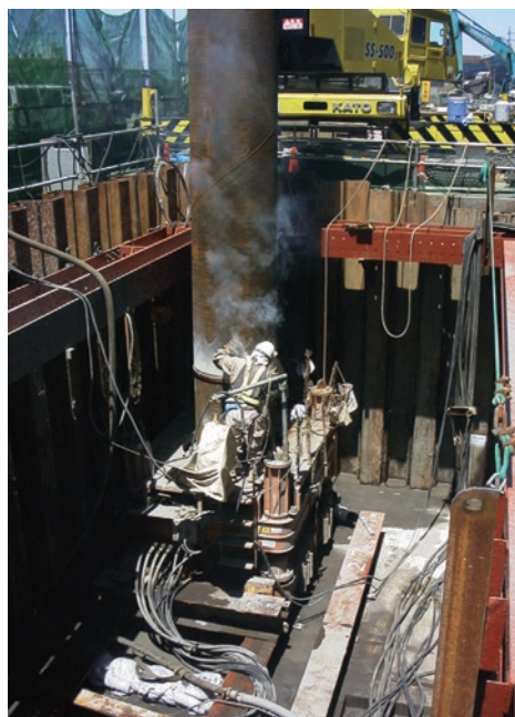
低空頭、狭隘な根切り底での施工
