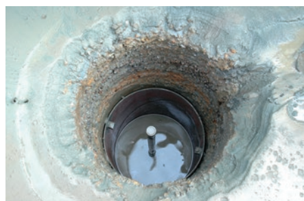
施工完了後の状況
