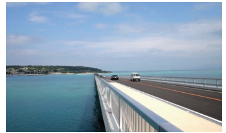
総幅員 10.25m、車道往復 2 車線、片歩道が設けられた 古宇利大橋
