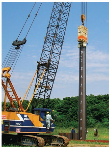
写真-2 パイプロ施工試験状況
