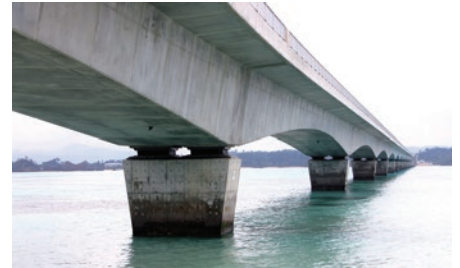
古宇利島側、A1 橋台部から屋我地島方向をみる
