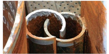
編鋼管継手嵌合状況
