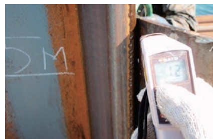
赤外線センサーによる継手部の温度管理
