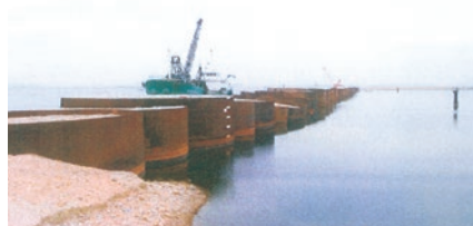
銅板セル式構造が採用された東護岸
