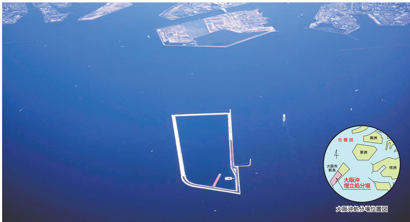
大阪沖処分場 空撮(平成21年9月6日)
