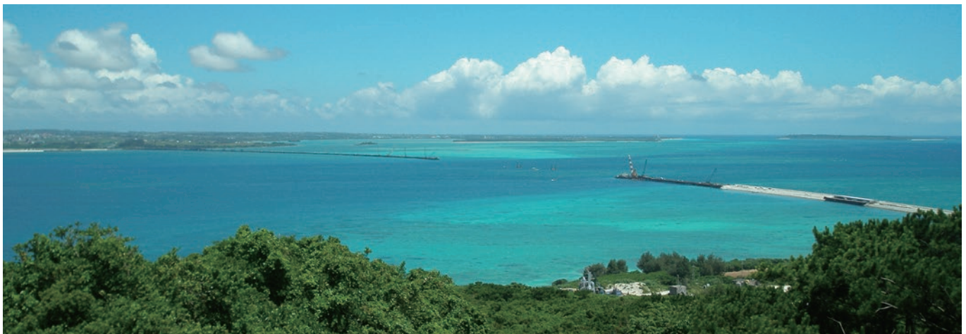
伊良部島牧山展望台より工事中の伊良部大橋を望む（2009年7月）
