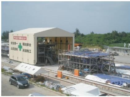
上部工セグメントを製作するヤード
