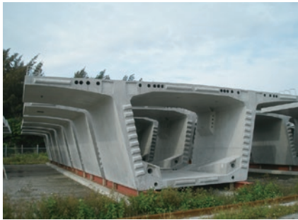
搬出を待つ上部工セグメント
