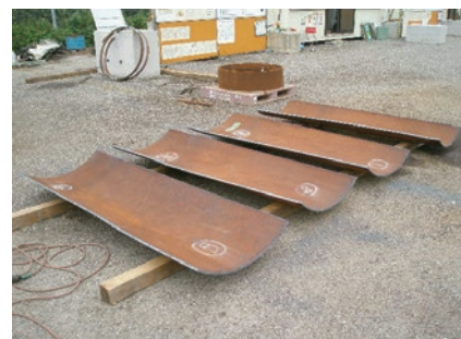
鋼管杭を4分割して作る円弧リブ
