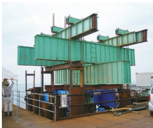
押込み載荷試験の状況
