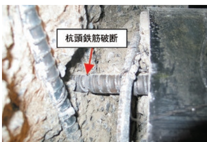
写真4 鉄筋の破断
