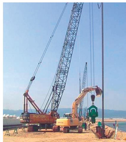
鋼矢板の打設状況
