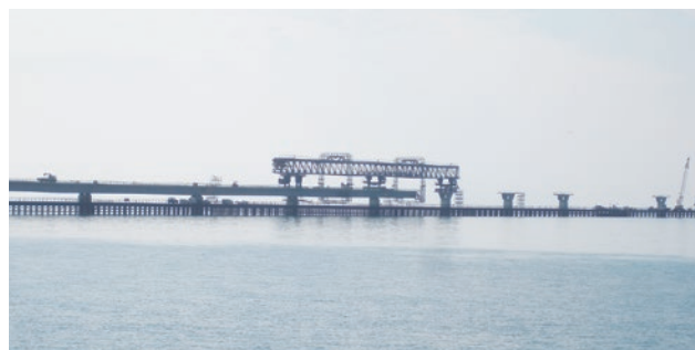
ガーターによる架設状況
