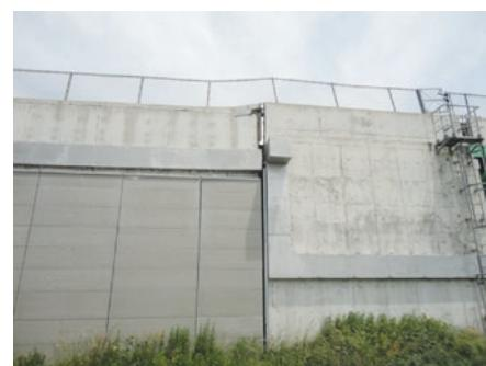
写真2.3 桁端部のずれ
