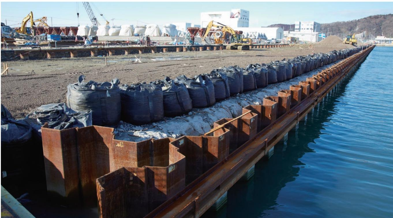
本港-7m岸壁で打設終了後控え工を行う鋼矢板の状況
