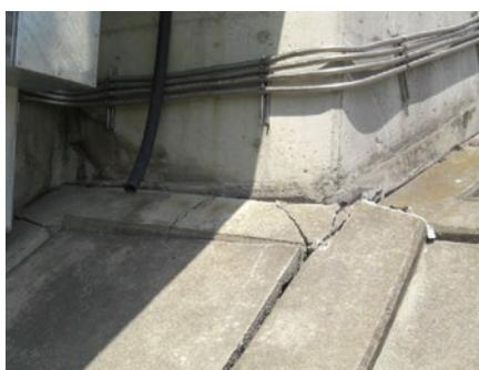
写真2.2 堤防法面のひび割れ
