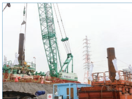
■左右2基の基礎を同時施工する
