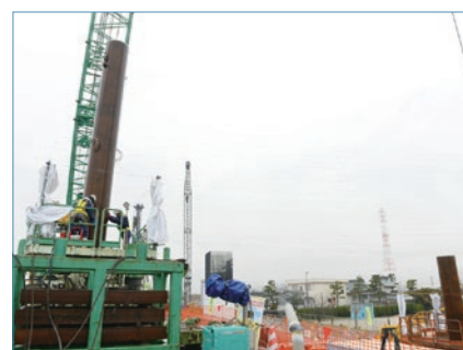
■小川地区橋脚、回転杭の建込み、および貫入の状況
