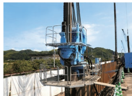
■打設済みの鋼矢板に併走することで施工性と省スペース性を両立させた圧入機
