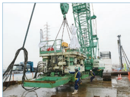
■全周回転機の移動、設置の状況
