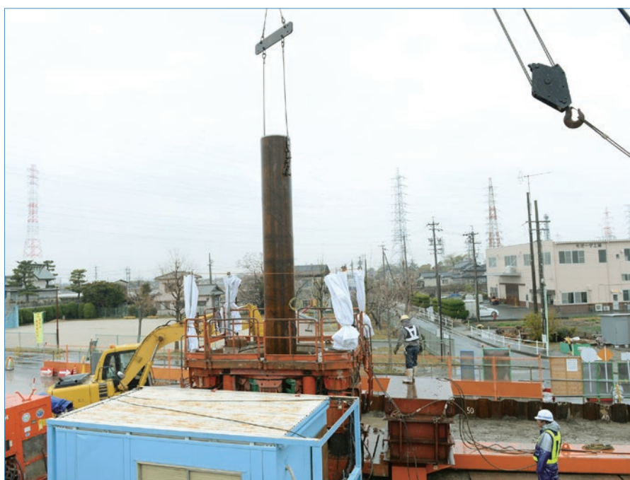
■回転杭工法の低騒音・低振動の特性が有効な施工現場
