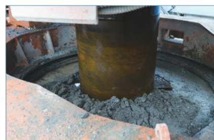
■杭先端の貫入状況
