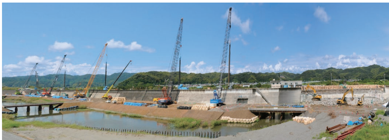
■専用圧入機を7機同時施工することで工期のスピードアップがはかれた
