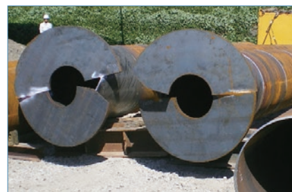
■名2環で採用されている回転杭の先端形状
