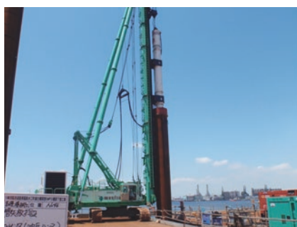
■ MP3での鋼管矢板打設状況
