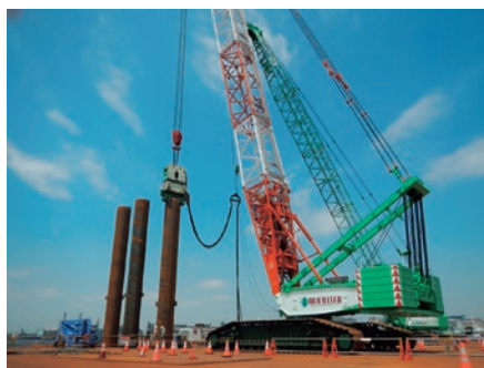
■ MP3での鋼管矢板打設状況
