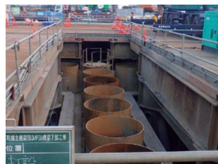
■ 上杭打設後の鋼管矢板 (MP3)
