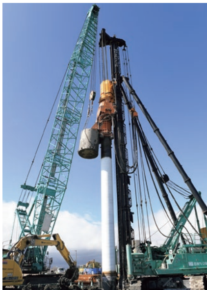
■ネガティブフリクションが予想される沖洲高架橋工区ではSL 杭も採用された
