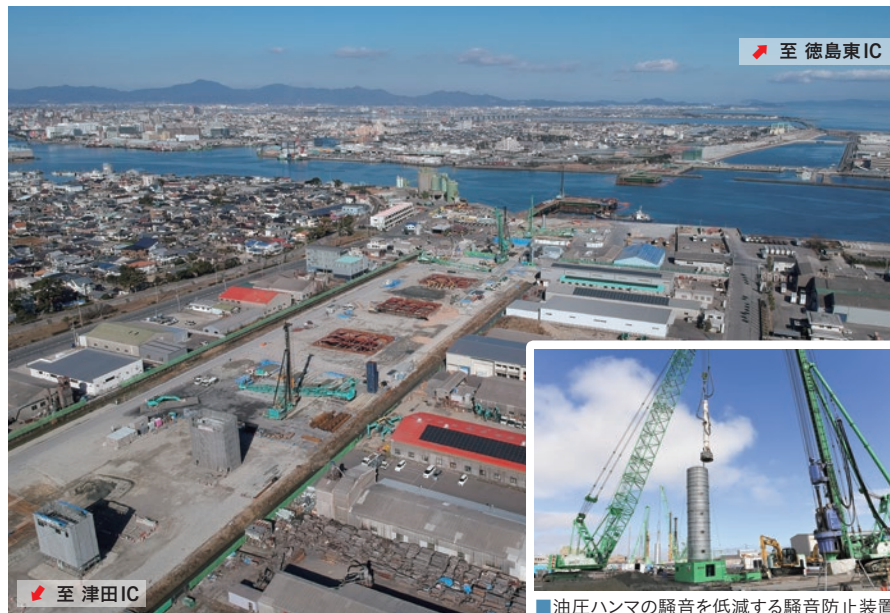
■津田高架橋側から見た工区全景
