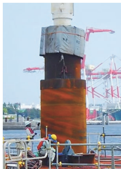
写真1 打撃工法の打止め管理の様子
