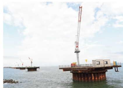
■吉野川河口部の施工が完了した鋼管矢板基礎
