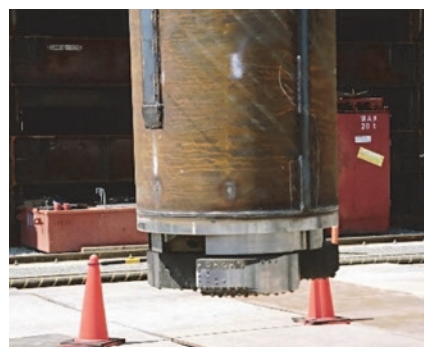
写真3 中掘り杭工法コンクリート打設方式の施工試験状況
