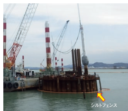
■シルトフェンスを設置し、自然環境へ配慮しながら行われた鋼管矢板基礎打設状況
