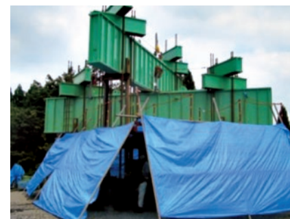
写真6 中掘り杭工法コンクリート打設方式の載荷試験状況
