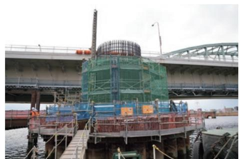
■ 鋼管矢板基礎の内側で進む橋脚の施工状況
