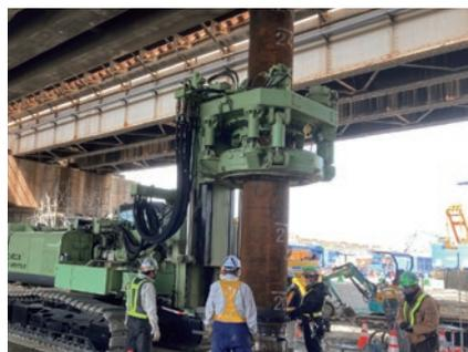
■ 低空頭・狭地施工機による回転杭の施工状況
