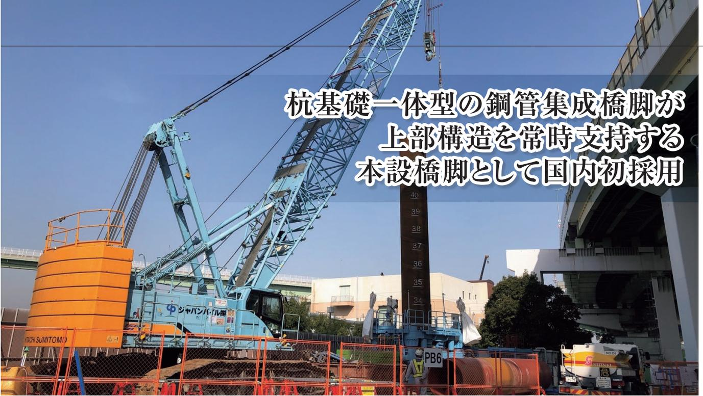
■海老江ジャンクション/鋼管集成橋脚の回転杭基礎、打設状況
