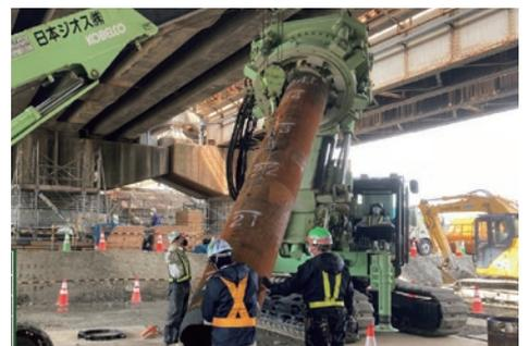
■ 低空頭・狭地施工機による回転杭の施工状況
