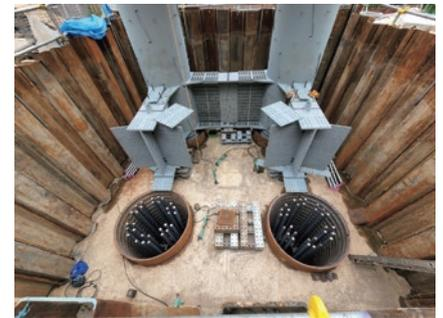
■鋼管集成橋脚、基部の架設状況
