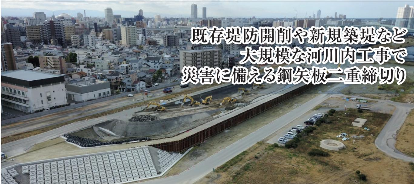
■ 淀川左岸線（2期）仮設堤防築造における、鋼矢板二重締切りの施工状況
