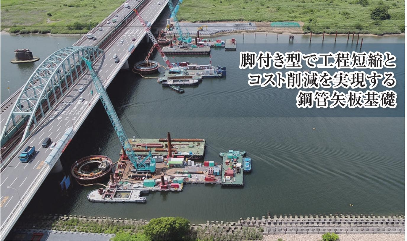
■ 淀川左岸線（2期） 新御堂筋に近接する豊崎工区での鋼管矢板基礎の施工状況
