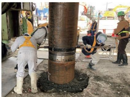
■ 機械式継手の施工状況
