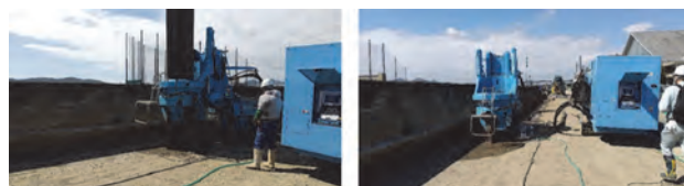
図3 サイレントバイラーによる鋼矢板圧入状況
