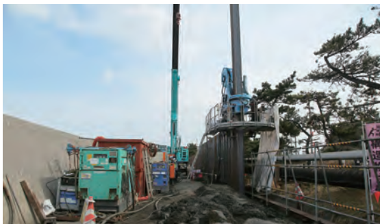
■鋼矢板の打設状況
