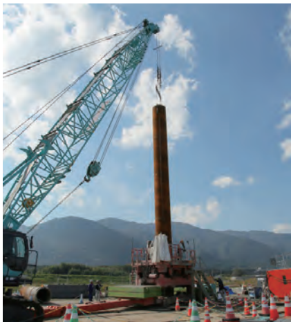
■ 海津高架橋P2橋脚、回転杭の施工状況
