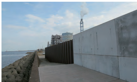
■矢板壁の築造から上部工（パラペット構築）まで完了した新設護岸
