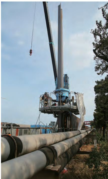
■鋼矢板の打設状況
