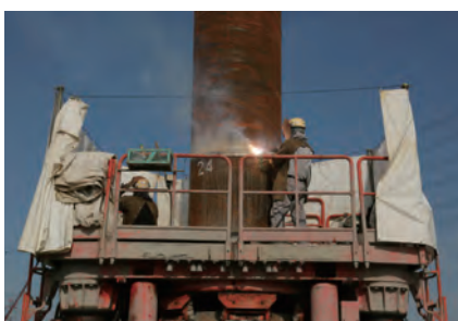
■ 養生シートを常置して高品質な溶接管理を行っている
