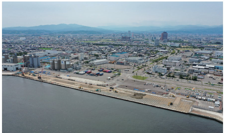
■2025年7月の金沢港・戸水ふ頭の復旧状況
