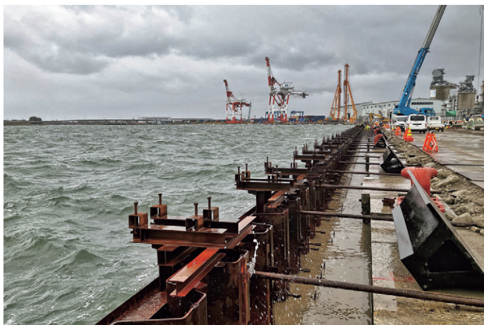
■打設後の鋼矢板配置状況
