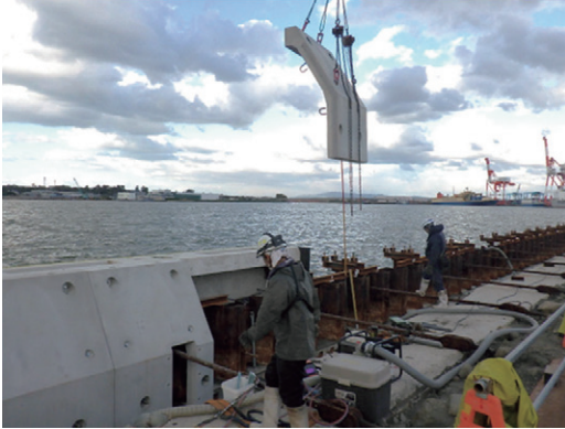
■プレキャスト上部工の設置
