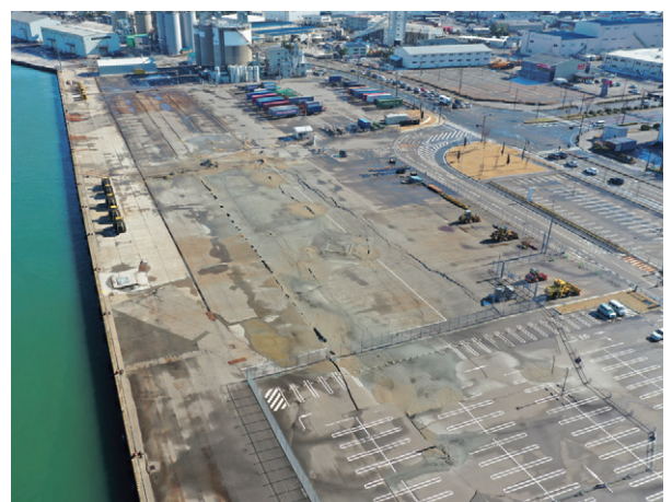
■ 金沢港・戸水ふ頭の被災状況 (2024年1月14日撮影)
