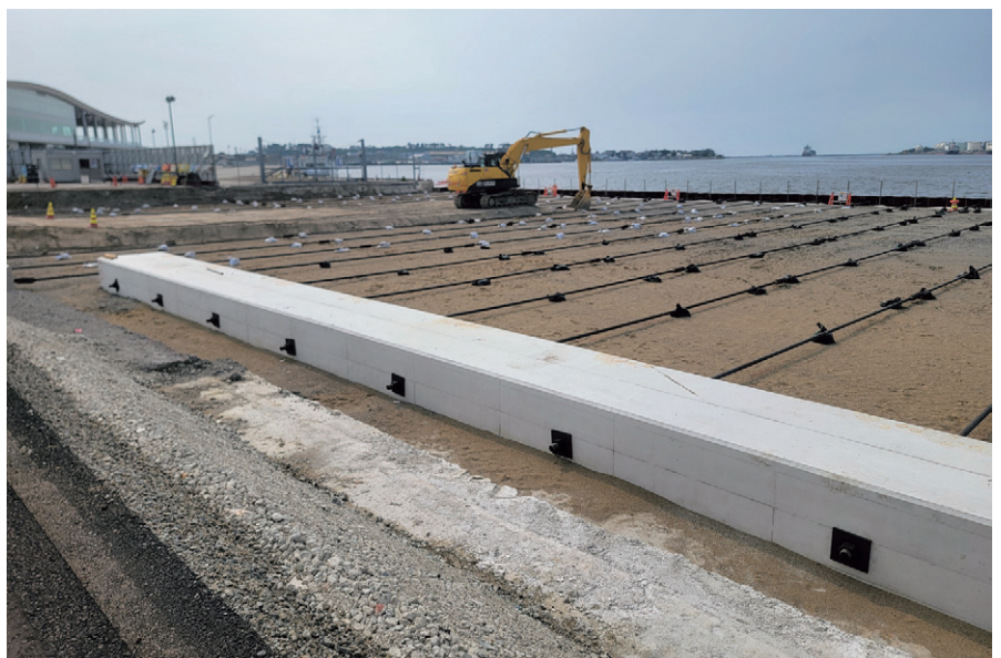
■タイロッドの施工状況
