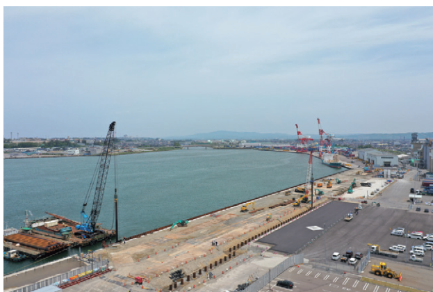
■海上台船からの鋼矢板の打設状況
