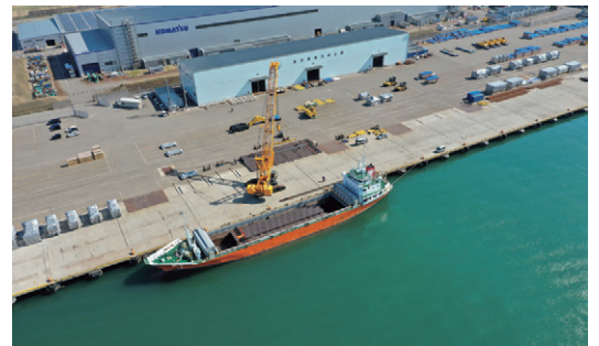
■大浜岸壁に搬入される鋼矢板
