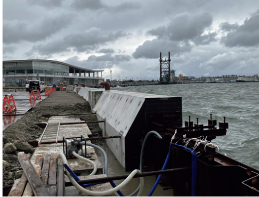
■プレキャスト上部工の設置状況
