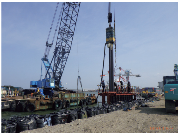
■鋼矢板の打設状況
