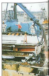
(5) 鋼管内の中詰め
