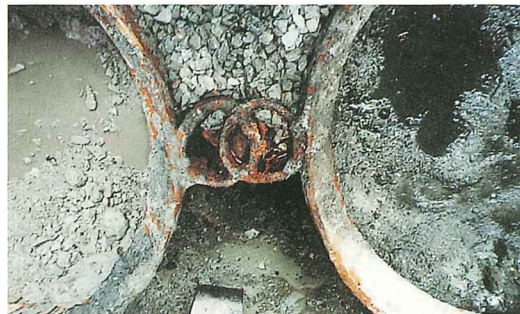
継手部調査の様子
