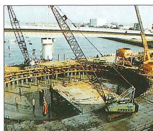
(3) 鋼管矢板の閉合
