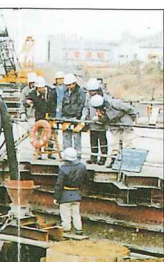
めコンクリート打設
