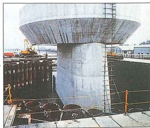
(9) 橋脚躯体の構築
