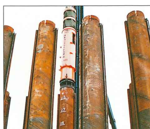
(2) 鋼管矢板の打設
