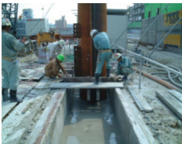
写真3 トレンチ工法（鋼管矢板建込み状況）
