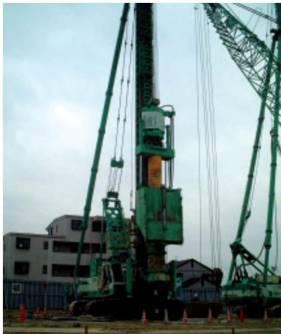
写真4 中掘り工法（鋼管矢板打設状況）
