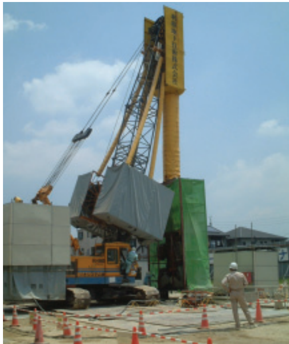
写真2 トレンチ工法（掘削状況）
