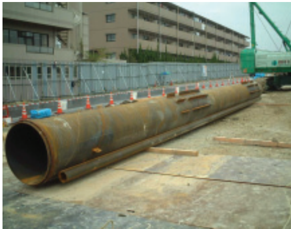
写真1 鋼管矢板
