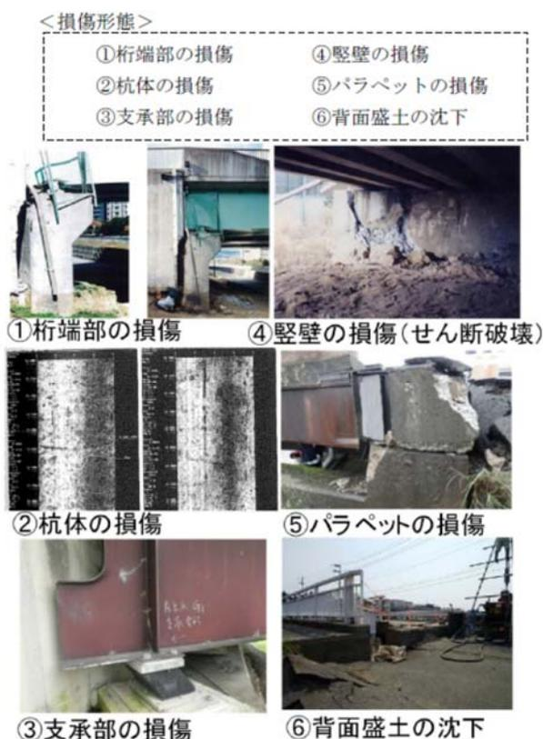
図-2.1.1 橋台の被災事例における損傷形態
