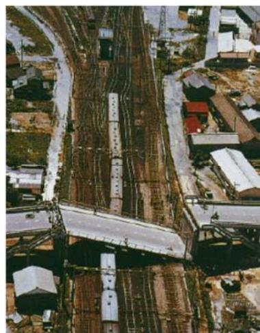
図-2.1.7 1964 年 新潟地震で落橋した東跨線橋<sup>3)</sup>
