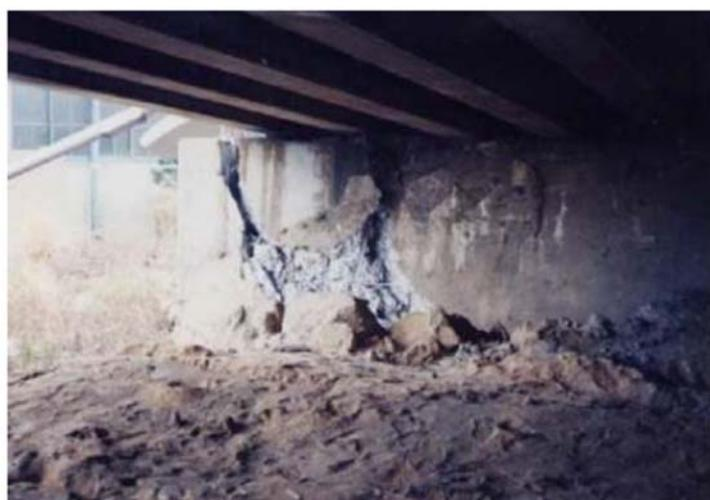
図-2.1.8 1995 年 兵庫県南部地震で下部構造が傾斜し損傷した東魚崎大橋<sup>9)</sup>
