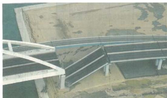
図-2.1.3 1995年 兵庫県南部地震で落橋した西宮港大橋アプローチ橋<sup>4)</sup>
