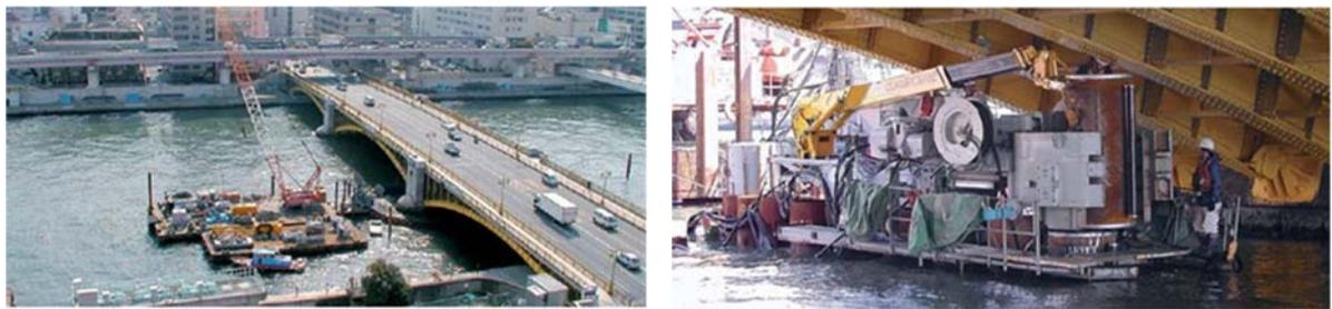
図-5.2.2 圧入工法による蔵前橋の耐震補強工事
