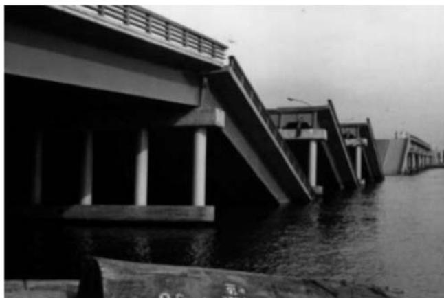
図-2.1.2 1964年 新潟地震で落橋した昭和大橋<sup>3)</sup>
