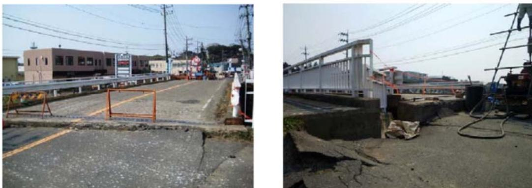
図-2.1.9 2011年東北地方太平洋沖地震で液状化により橋台背面に沈下が生じた橋の一例<sup>1)</sup>
