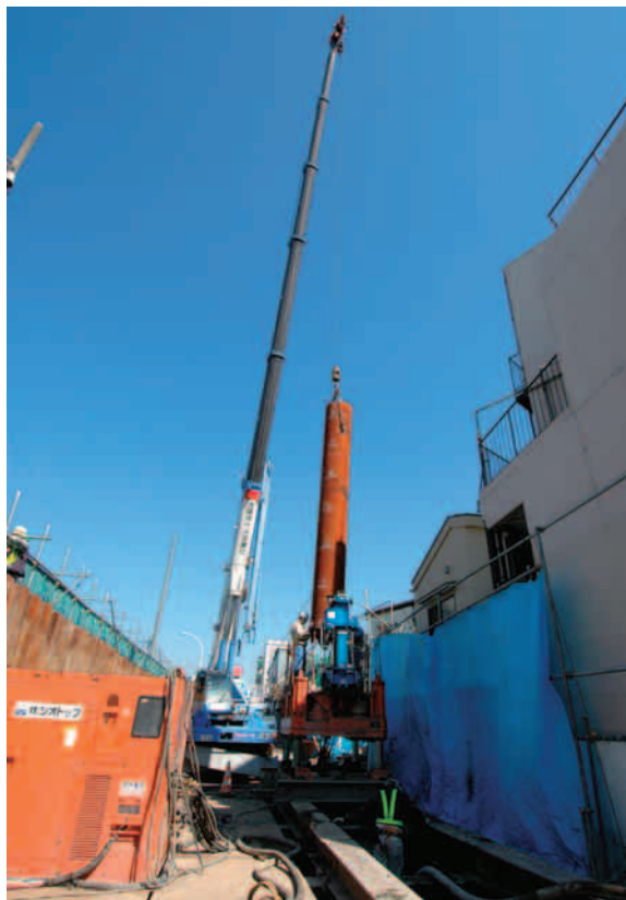
住宅が隣接する狭隘な現場
