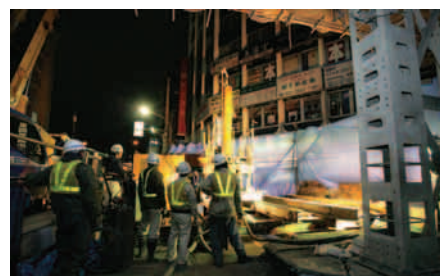
杭施工の急速性を活かし短時間で施工がすすむ
