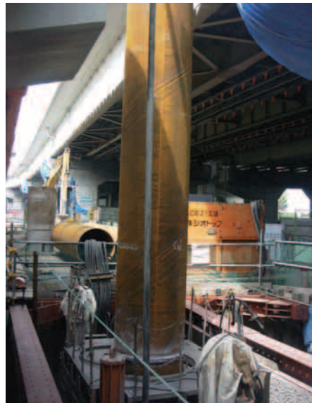
低空頭下での鋼管杭施工状況
