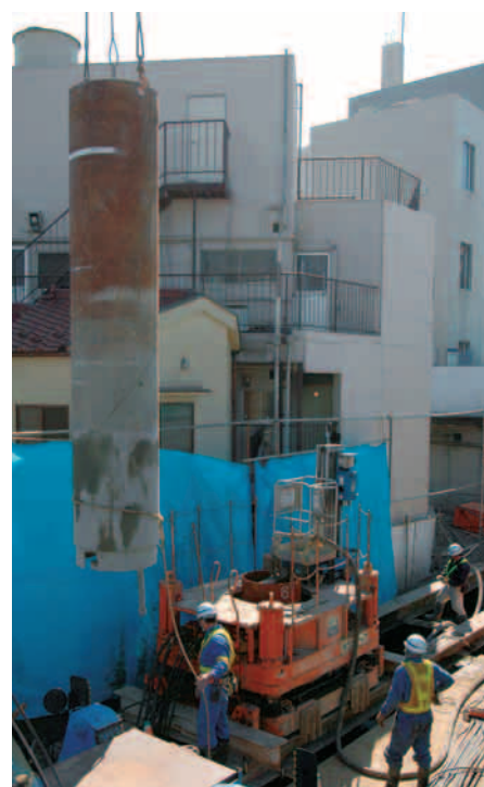
小型・軽量の杭打機での施工が可能
