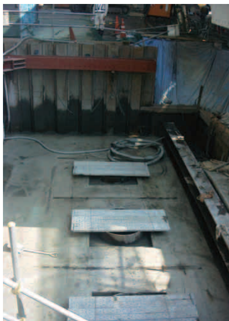
施工後の状況
