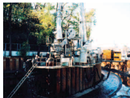
圧入工法による打設の様子
