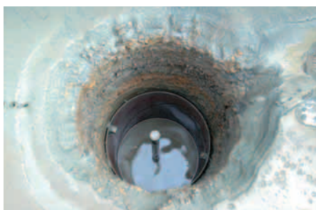
施工完了後の状況
