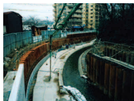
新護岸、および既存護岸の根固めに打設された鋼管矢板
