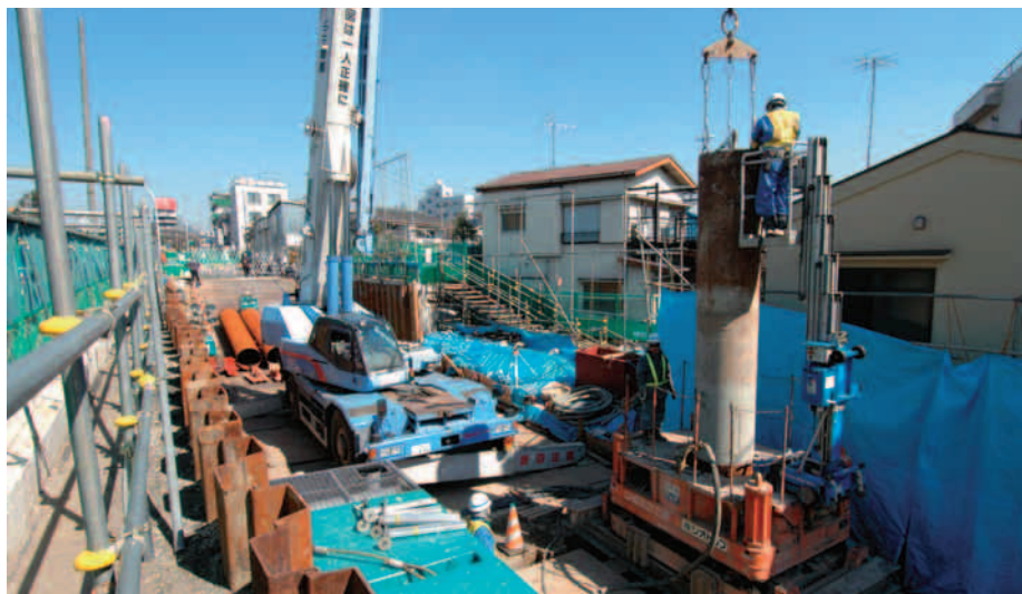
官民境界 60cm という狭隘な現場での特殊施工
