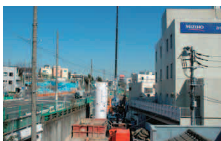
現場周辺の概況
