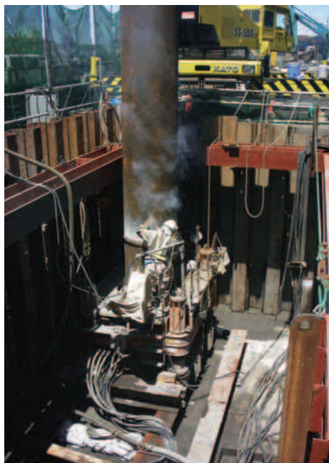
低空頭、狭隘な根切り底での施工
