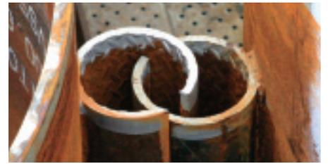
縞鋼管継手嵌合状況
