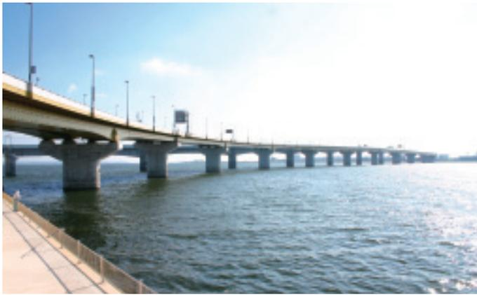
りんくうIC側からの道路連絡橋。15橋脚に1万4000トンの鋼管矢板が使用されている
