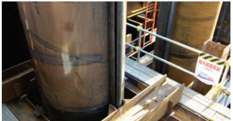
導棒を用いた鋼管矢板の施工状況
