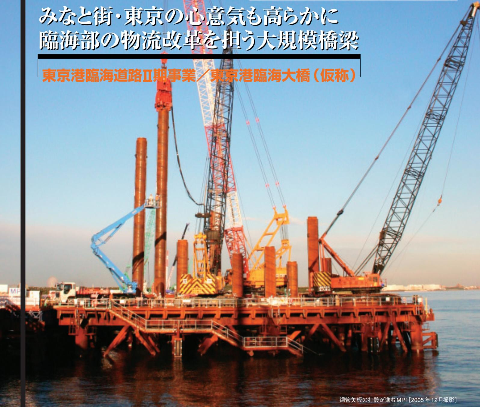
鋼管矢板の打設が進む MP1 [2005年12月撮影]
