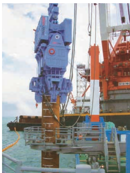
パイルキーパーを用いた鋼管杭打設状況
