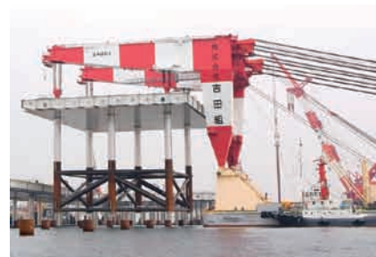
栈橋部ジャケット据付状況
