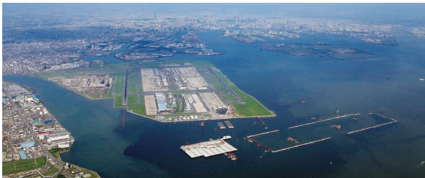
D滑走路建設工事全景（2008年9月24日）
