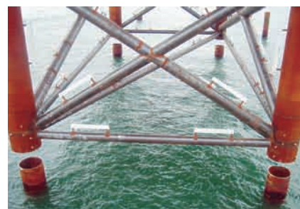
鋼管杭へのジャケット挿入の状況
