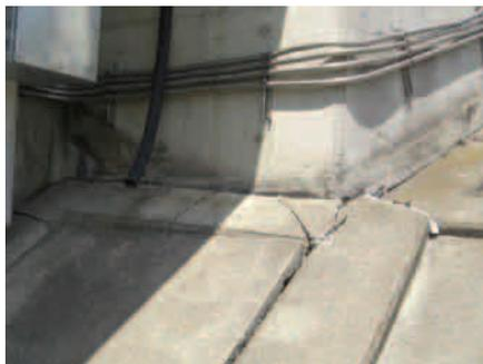
写真2.2 堤防法面のひび割れ
