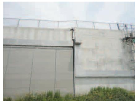
写真2.3 桁端部のずれ
