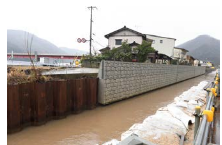
■景観に配慮した化粧型枠を用いた上部工パラベット
