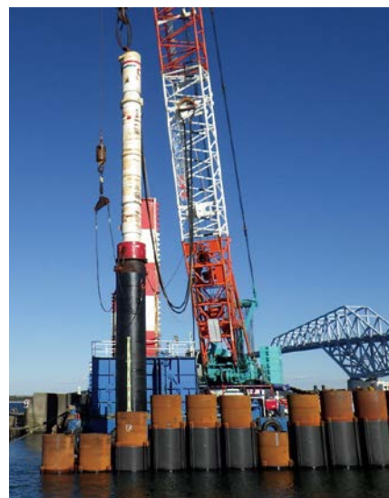
■東側締切堤、油圧ハンマによる鋼管矢板の打設状況※13
