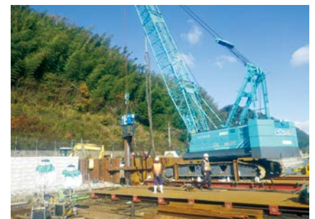
■パイプロハンマ工法による鋼矢板打設状況
