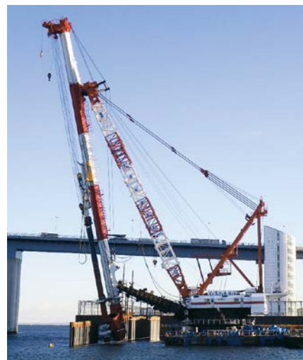
■東側締切堤、リーダー式杭打船による斜杭の打設状況※14
