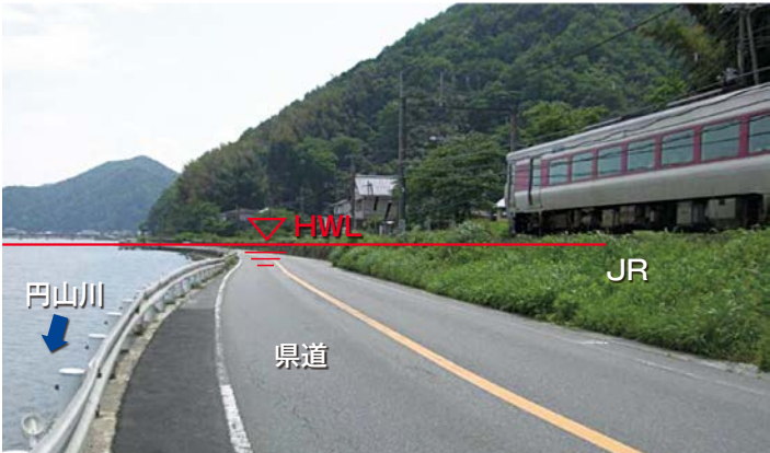
■円山川本川左岸3.8k付近の無堤地区の状況（平成24年5月）
