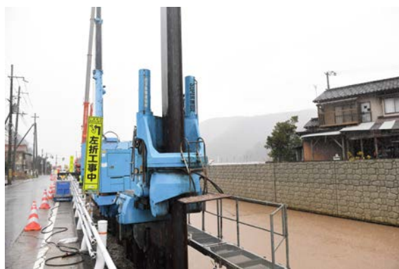
■低振動・低騒音の圧入機を用いて打設される
