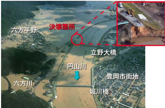
■平成16年10月23日、円山川立野地区の堤防決壊の状況
