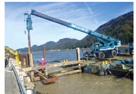
■ダウンザホールハンマによる掘削後の鋼矢板打設状況
