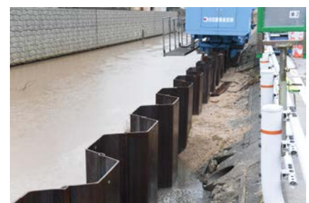
■圧入後の鋼矢板の状況
