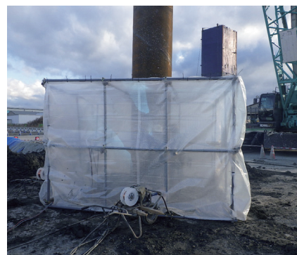
■移動式防風ハウスを用いた現場縦継ぎ溶接状況
