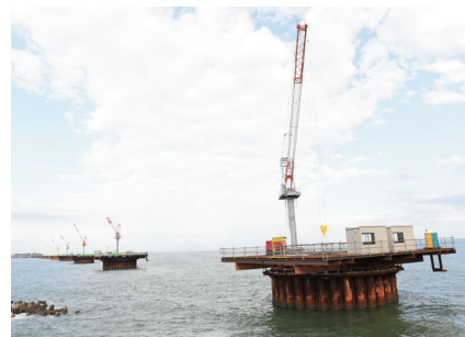
■吉野川河口部の施工が完了した鋼管矢板基礎
