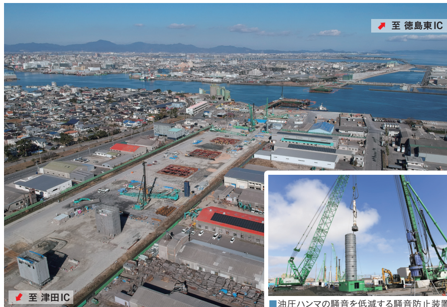
■津田高架橋側から見た工区全景
