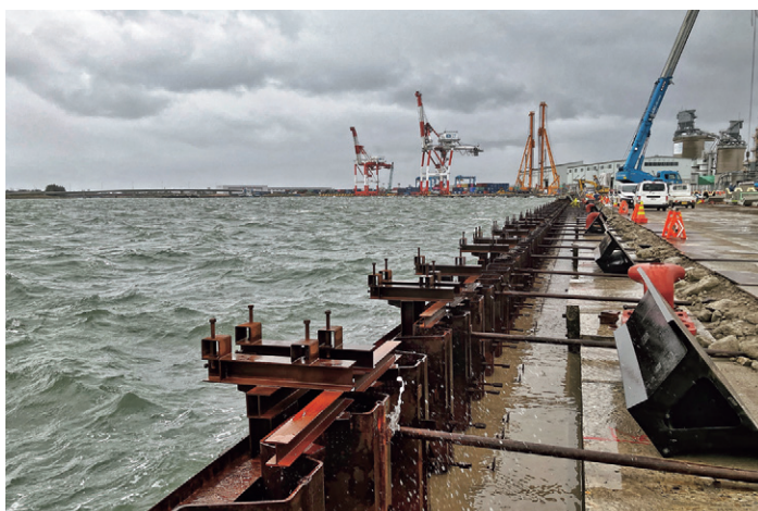
■打設後の鋼矢板配置状況
