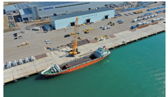
■大浜岸壁に搬入される鋼矢板
