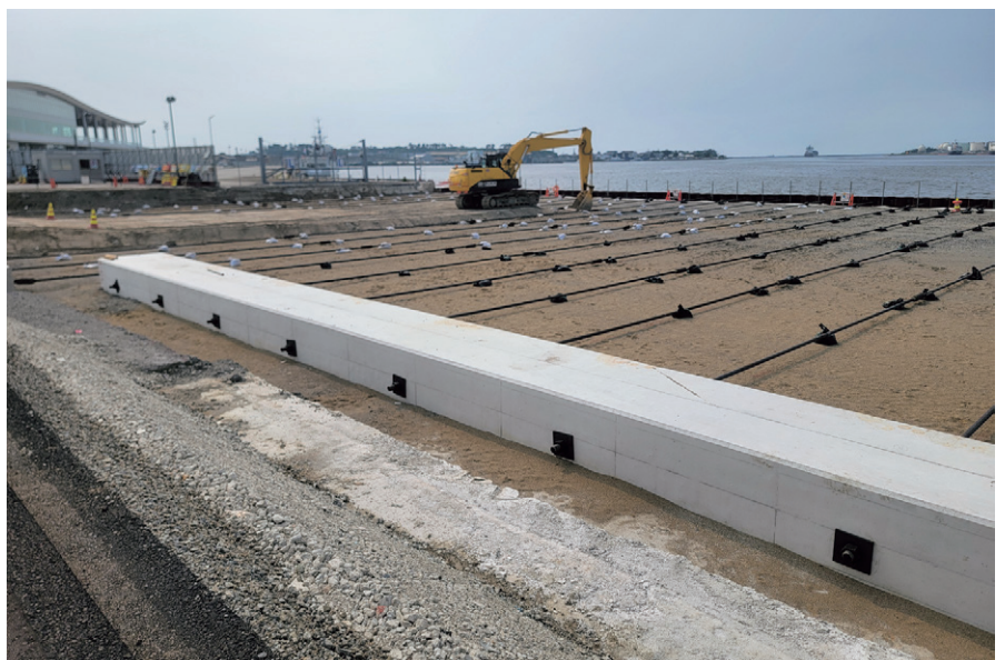
■タイロッドの施工状況
