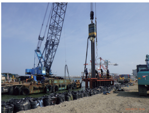
■鋼矢板の打設状況
