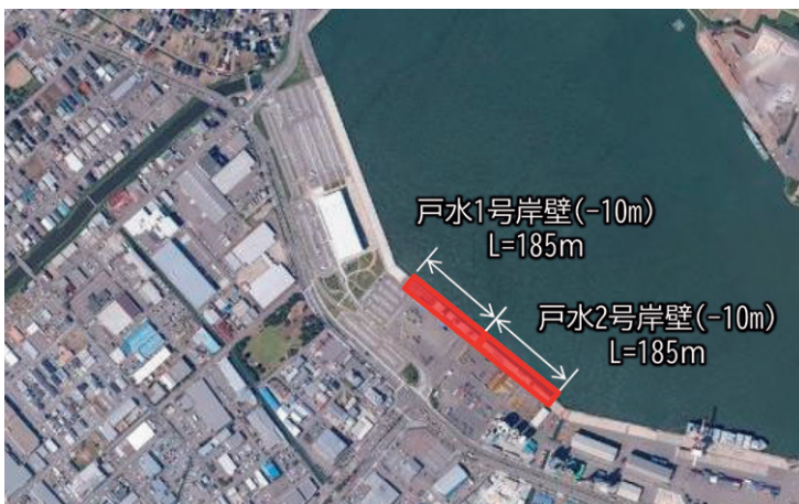
■ 金沢港・戸水ふ頭の被災箇所
