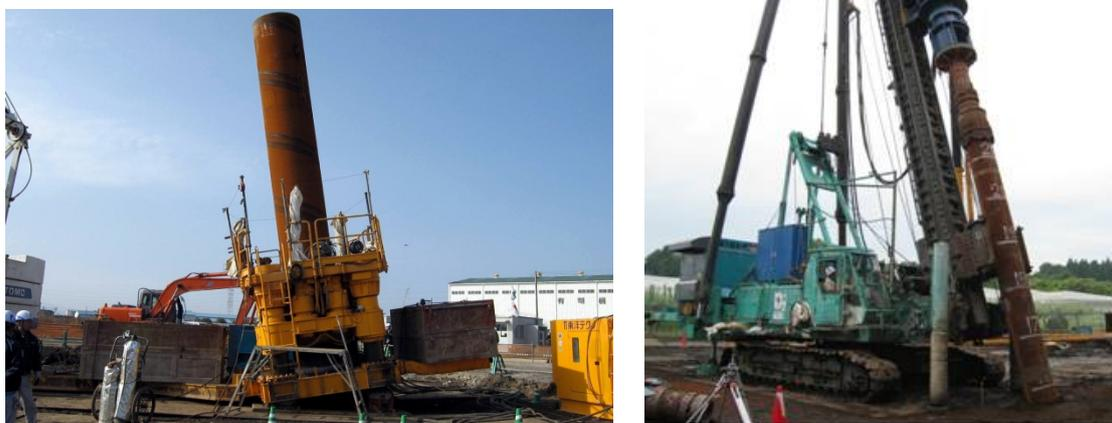
写真－4.6 斜杭の施工状況
