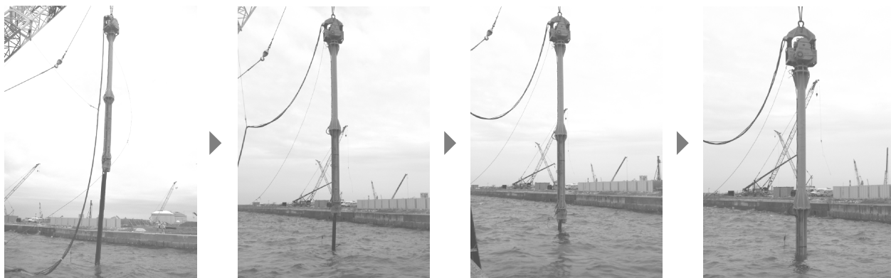
写真-9.17.1 ヤットコアアダプタを使用したの施工例
