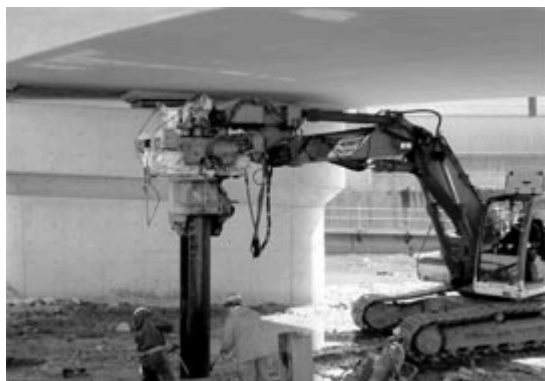
図-9.18.1 バイブロハンマ工法の例(調和工業(株)：CHV-200)
