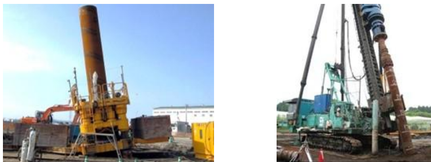
写真 5.8.7 斜杭の施工状況（出典 5.8-16 ）
