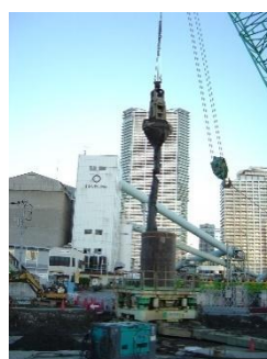
写真 5.2.2 RC 杭の撤去
