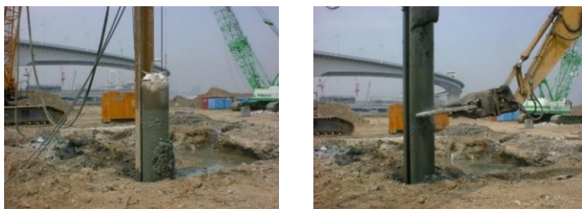
写真 5. 2. 4 PC 杭の撤去
