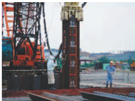
写真-4 打設状況 (U-1)
