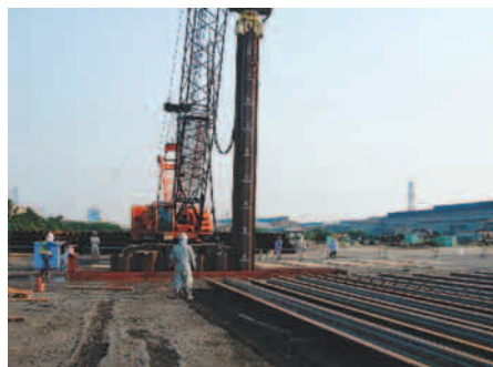
写真-3 打設状況 (A-30)
