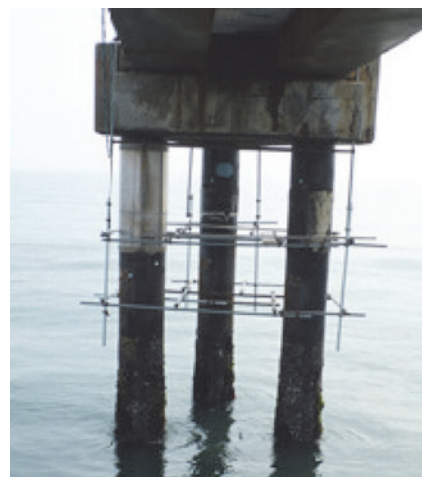
写真1 外観写真（杭No.33、34、35）
