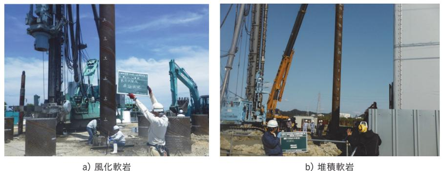
写真1 鋼管ソイルセメント杭工法の施工試験状況
