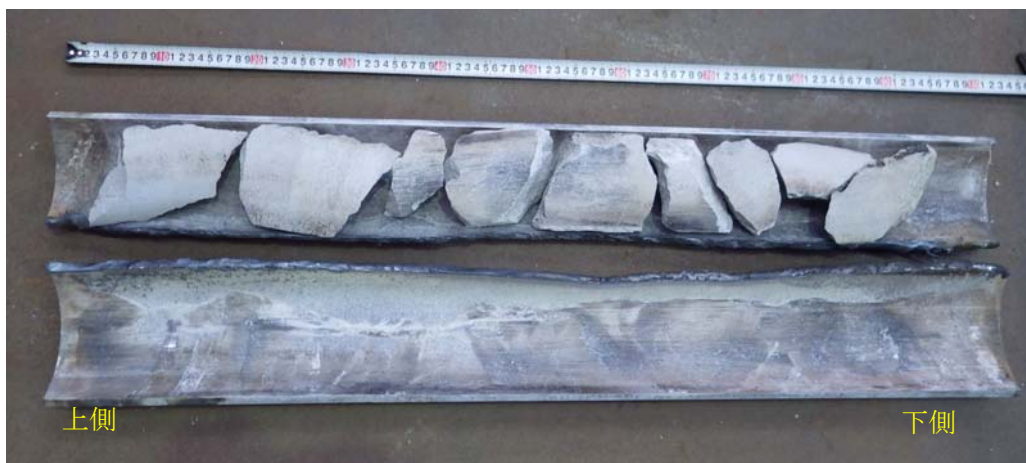
写真 2.5 B 室のモルタルグラウトの状況
