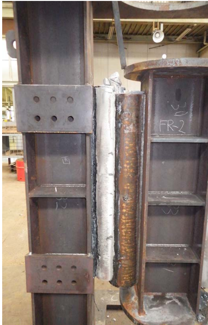
写真 2.4 A 室のモルタルグラウトの状況
